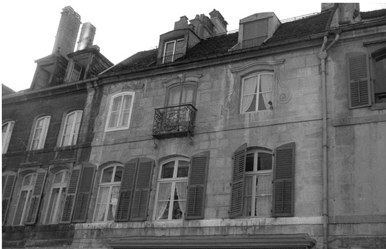
Façade antérieure : les étages.
