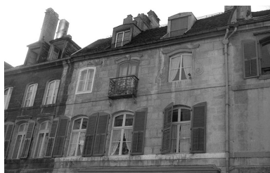
Façade antérieure : les étages. IVR43_19682500199Z
