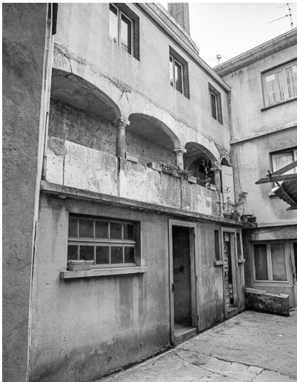
Galerie sur cour intérieure.
