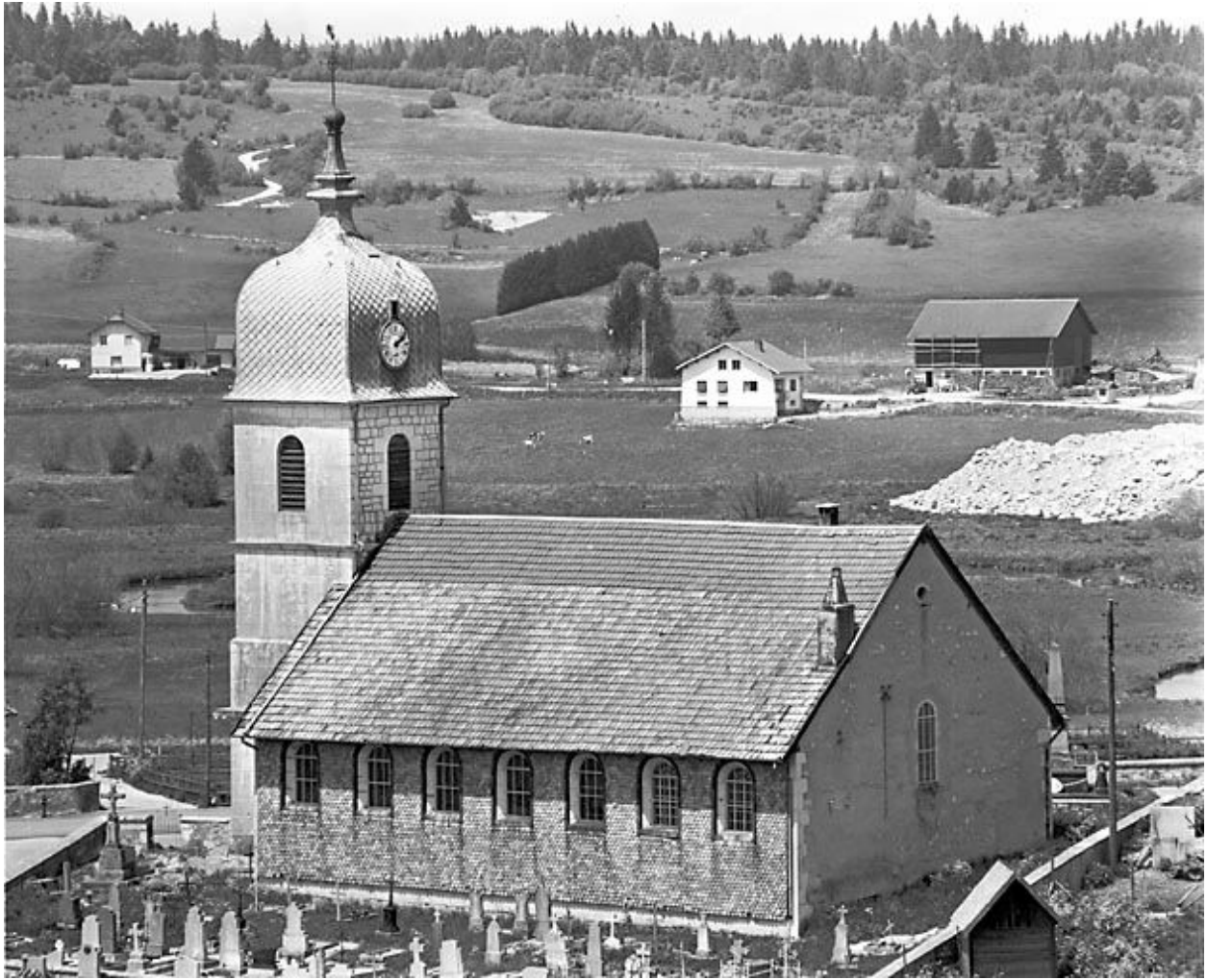
Façades postérieure et latérale droite.
