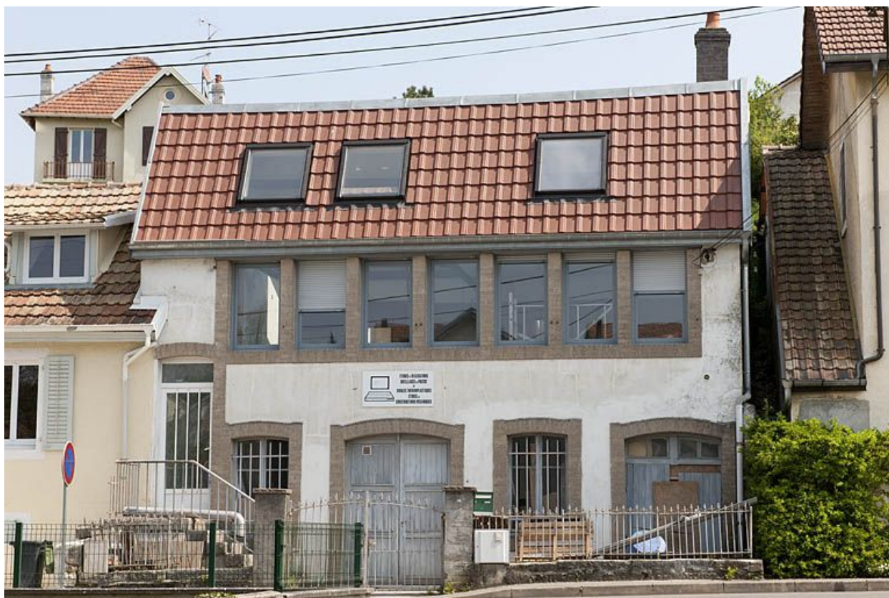
Façade ouest de l'atelier de fabrication.
