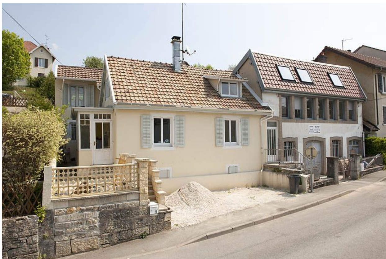
Logement et atelier depuis le nord-ouest.
