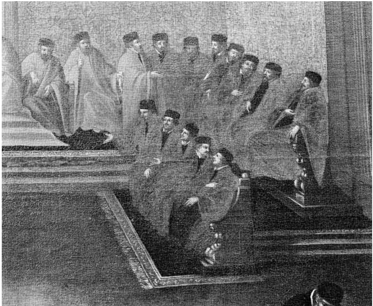
Détail de la partie droite.
