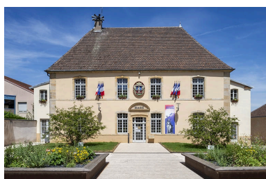
La façade de l'hôtel de ville. Phot. Jérôme Mongreville IVR43_20217000394NUC4A
