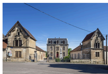
L'ancienne école libre, au n° 29. Phot. Jérôme Mongreville IVR43_20217000398NUC4A
