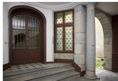
Vue de l'entrée de l'escalier. Phot. Yves Sancey IVR43_20072500280NUCA
