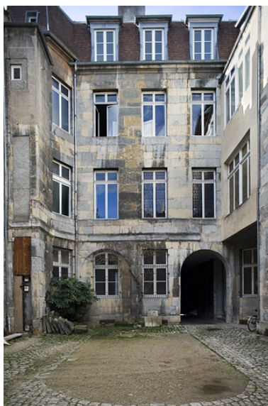
Vue d'ensemble des façades sur cour depuis le fond de la parcelle. Phot. Yves Sancey IVR43_20072500284NUCA
