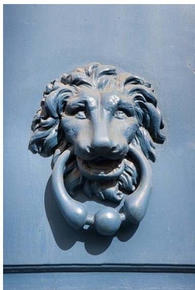
Détail du heurtoir du portail d'entrée : vue rapprochée. Phot. Yves Sancey IVR43_20072500287NUCA
