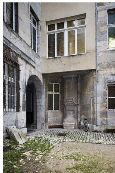
Vue d'ensemble de l'entrée sur cour. Phot. Yves Sancey IVR43_20072500285NUCA
