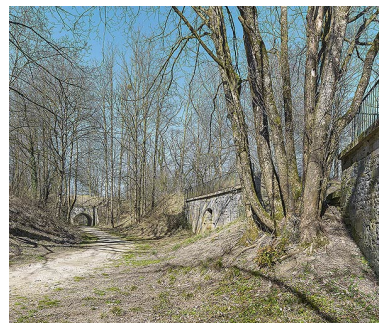
Traverse-abri, rue des Remparts.
