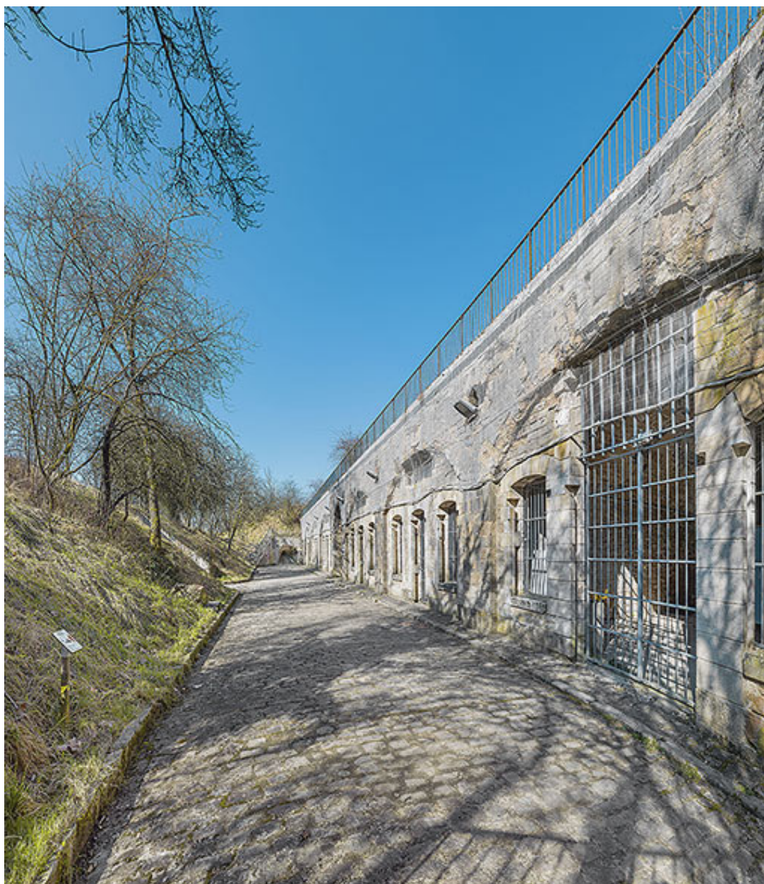
Le casernement de la redoute.
