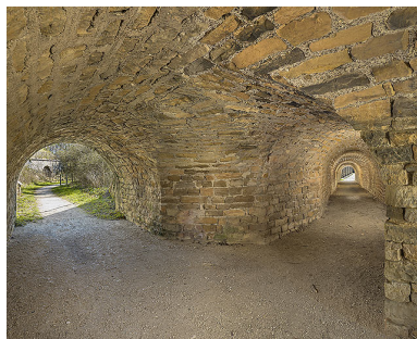
Galeries couvertes et accès vers la rue des Remparts (à gauche).
