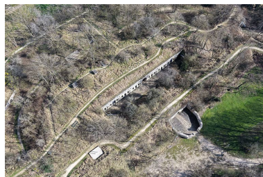
Le ravelin et l'espace de casernement de la redoute. (vue aérienne). Phot. Nicolas Douriaux IVR26_20262100357NUC4A
