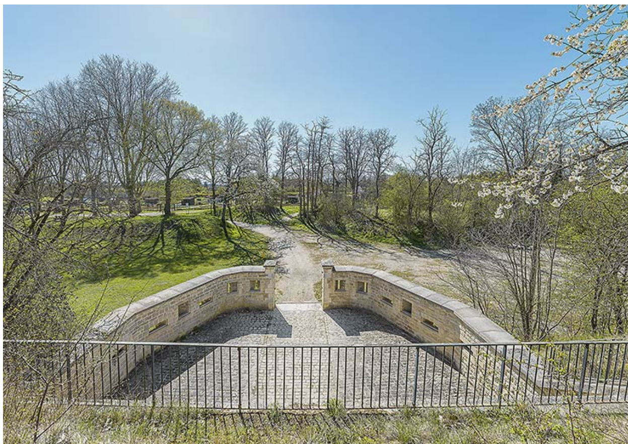
Le ravelin depuis la terrasse des casernes.
