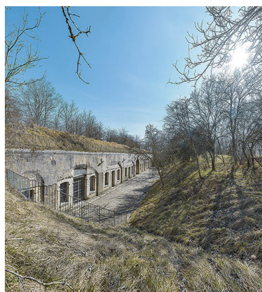
L'espace de casernement et sa cour. Phot. Thierry Kuntz IVR26_20252100113NUC4A
