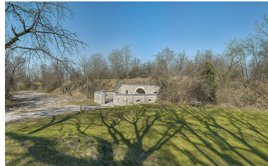
La redoute dans son environnement actuel. Phot. Thierry Kuntz IVR26_20252100107NUC4A
