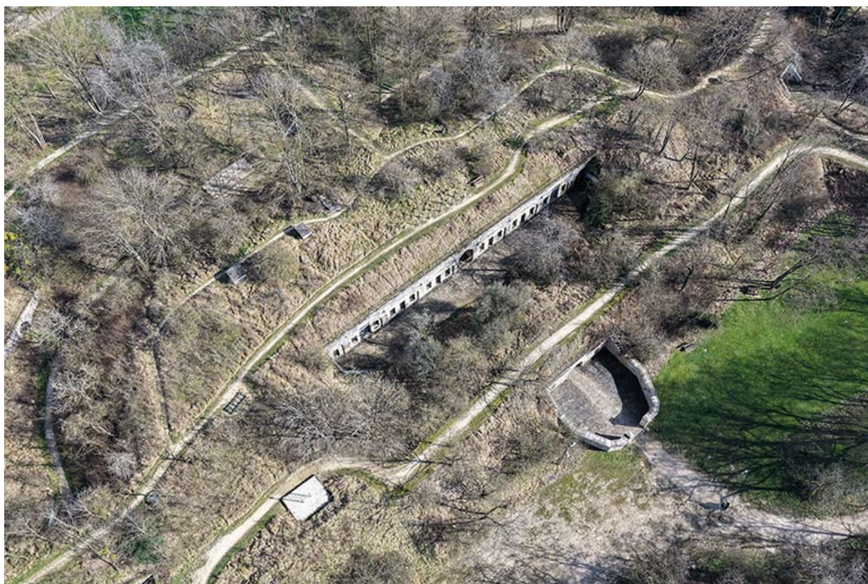
Le ravelin et l'espace de casernement de la redoute. (vue aérienne).
