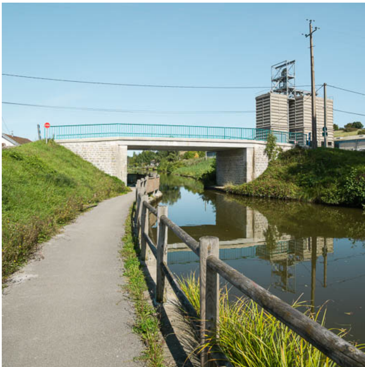
Vue d'ensemble du pont.
