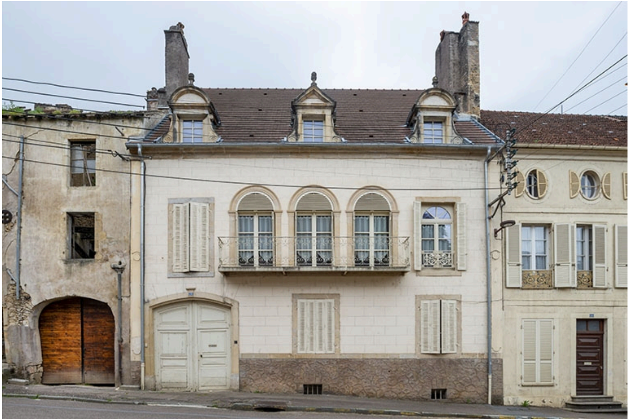
La façade antérieure.
