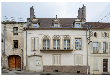
La façade antérieure. Phot. Jérôme Mongreville IVR43_20217000229NUC4A
