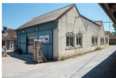
Atelier de fabrication (scierie). Phot. Jérôme Mongreville IVR43_20152501372NUC4A
