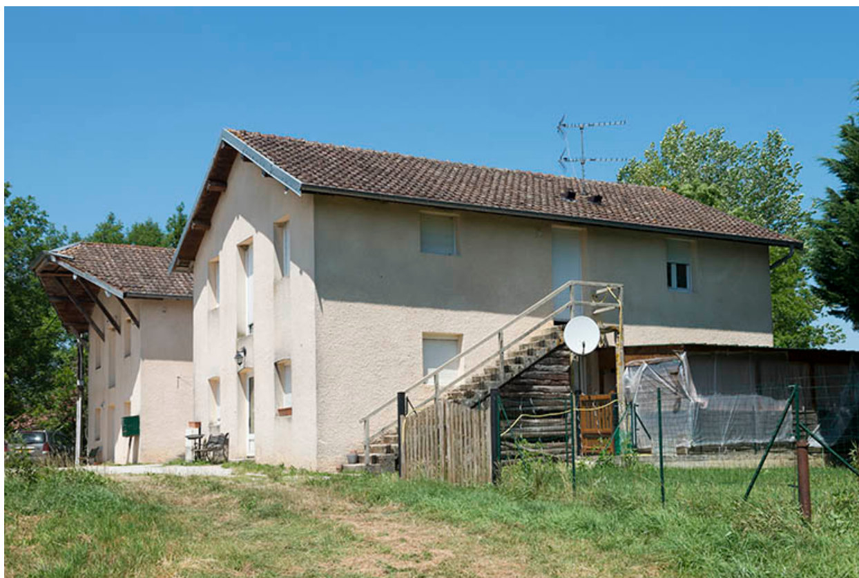
Logements, à l'est du site.
