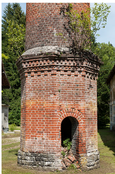
Base de la cheminée. Phot. Jérôme Mongreville IVR43_20152501484NUC4A
