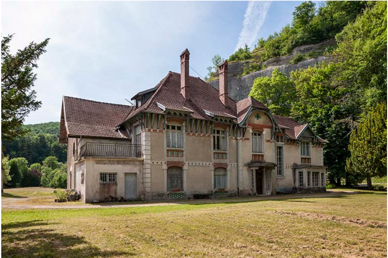
Façade est du logement patronal.
