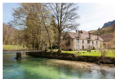
Logement patronal depuis le nord-ouest. Phot. Jérôme Mongreville IVR43_20152501071NUC4A
