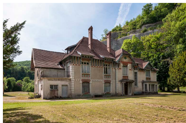
Façade est du logement patronal. Phot. Jérôme Mongreville IVR43_20152501478NUC4A
