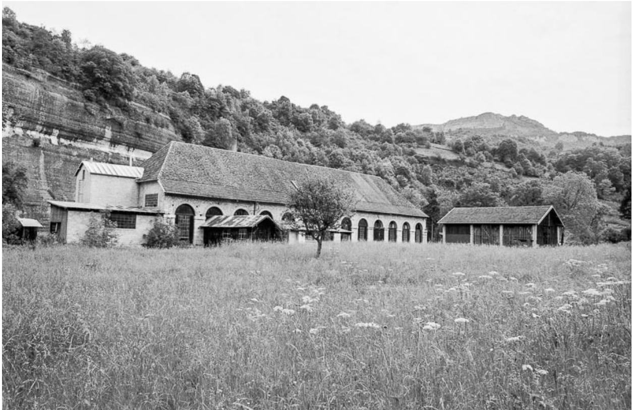
Vue d'ensemble depuis le sud en 1980.
