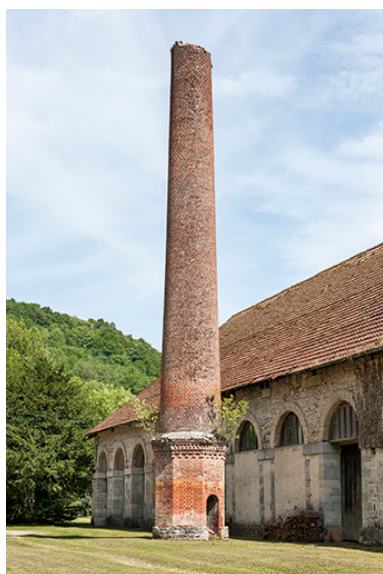
Cheminée de la tuilerie. Phot. Jérôme Mongreville IVR43_20152501485NUC4A
