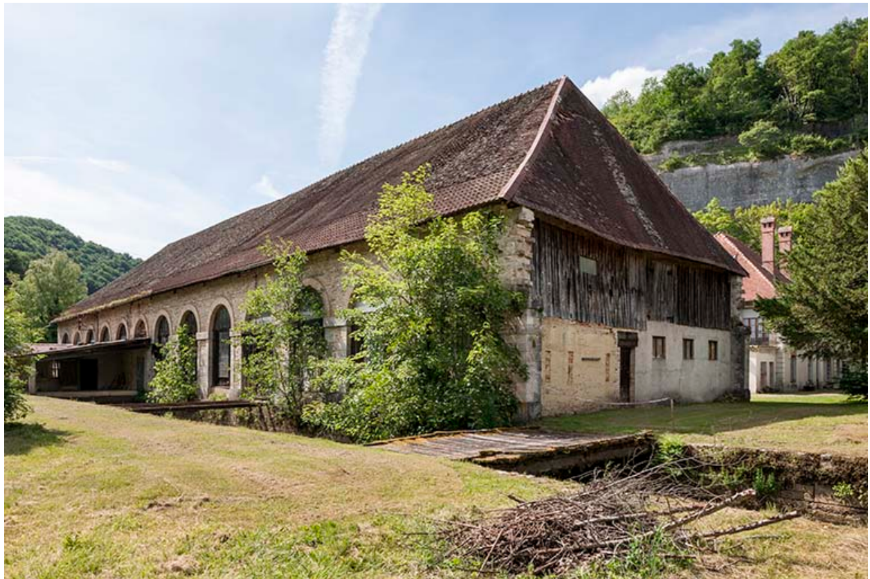
Atelier de fabrication depuis le sud-est.
