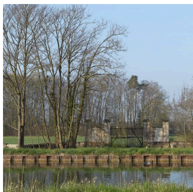
Portail du parc du château de Longecourt donnant sur le canal. Phot. Thierry Kuntz IVR26_20112103195NUC4A
