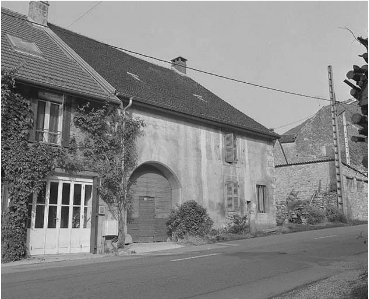
Façade antérieure vue de trois quarts gauche.
