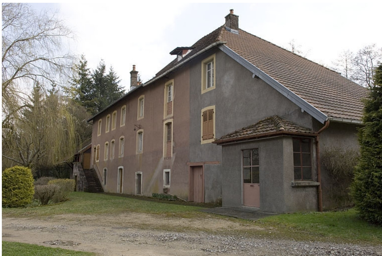
Façade antérieure depuis l'ouest.
