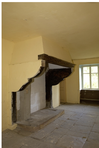
Logement. Cheminée de la cuisine. Phot. Jérôme Mongreville IVR43_20057000523NUCA
