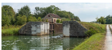
Vue d'aval. Phot. Pierre-Marie Barbe-Richaud IVR26_20128900555NUC4AQ
