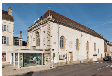
Façades antérieure et latérale droite. Phot. Pierre-Marie Barbe-Richaud IVR26_20238900397NUC4A
