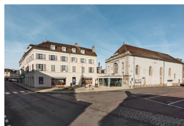
Vue d'ensemble, depuis l'est. Phot. Pierre-Marie Barbe-Richaud IVR26_20238900398NUC4A
