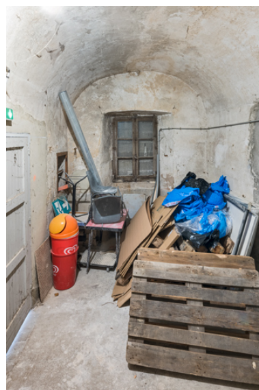
Corps nord-ouest : pièce voûtée au rez-de-chaussée. Phot. Pierre-Marie Barbe-Richaud IVR26_20238900407NUC4A
