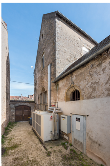
Façade postérieure, vue en enfilade. Phot. Pierre-Marie Barbe-Richaud IVR26_20238900412NUC4A
