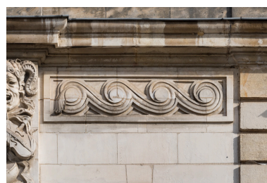
Façade antérieure : partie supérieure avec décor de postes. Phot. Pierre-Marie Barbe-Richaud IVR26_20238900392NUC4A
