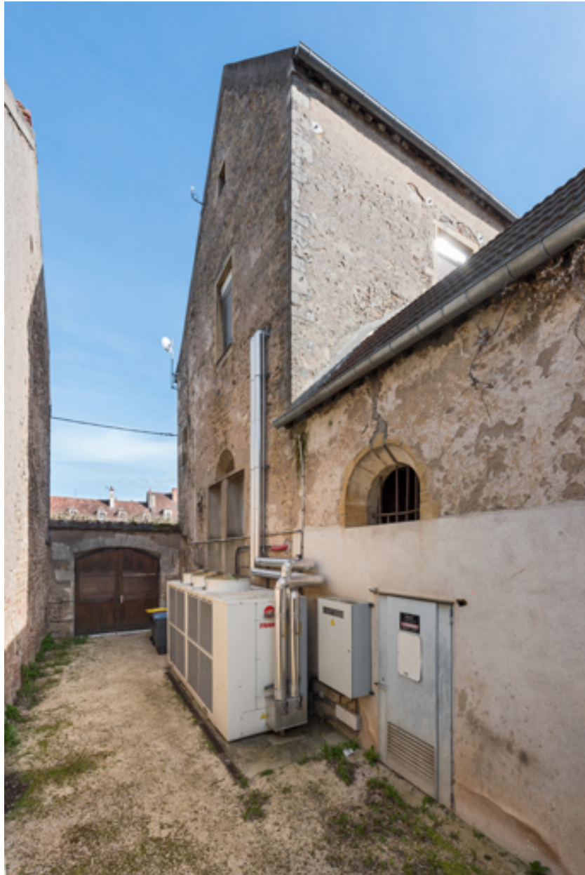
Façade postérieure, vue en enfilade.
