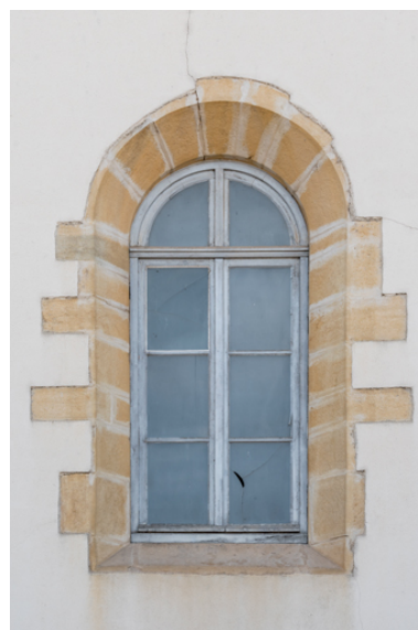
Façade latérale droite : une fenêtre. Phot. Pierre-Marie Barbe-Richaud IVR26_20238900413NUC4A
