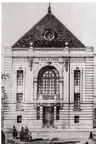
[Façade antérieure du théâtre]. S.d. [1er quart 20e siècle, après 1910]. Phot. Pierre-Marie Barbe-Richaud, Autr. auteur inconnu IVR26_20238900416NUC4A
