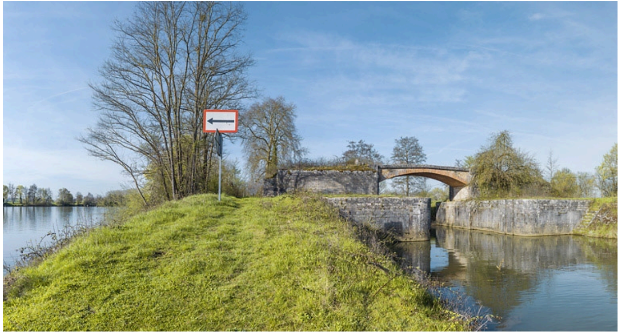
L'entrée de l'ancienne dérivation, rive droite.
