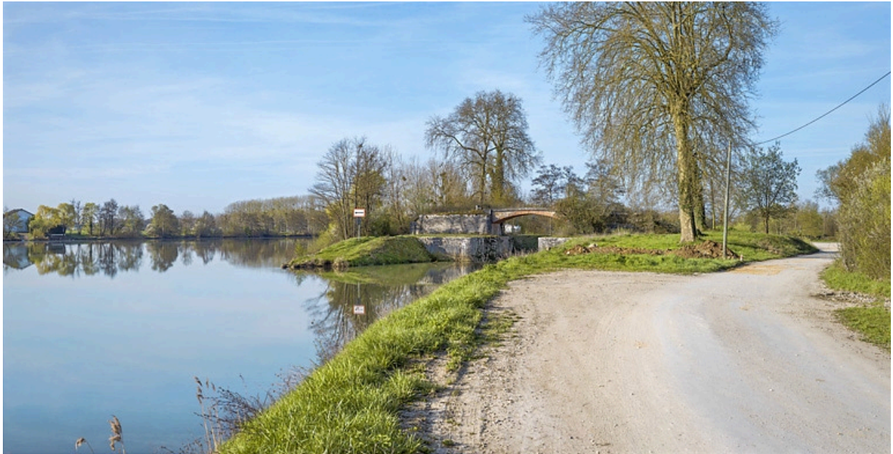
L'entrée de l'ancienne dérivation, rive droite.
