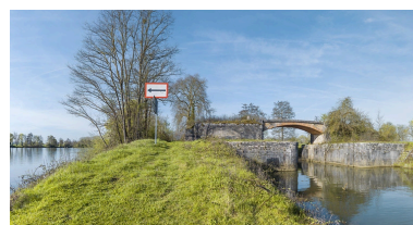
L'entrée de l'ancienne dérivation, rive droite.
