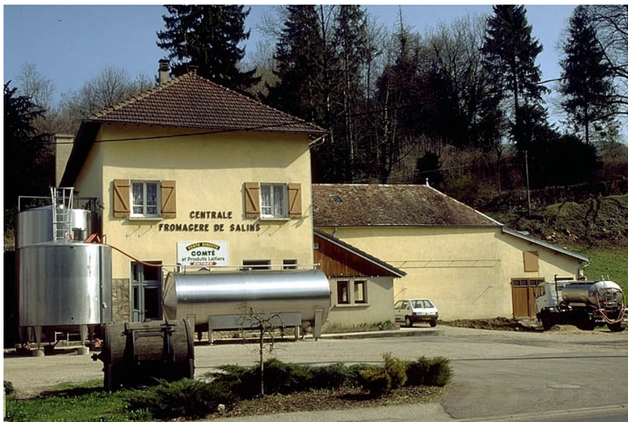
Façade antérieure depuis la route.
