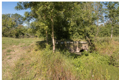
Vue du ponceau.
