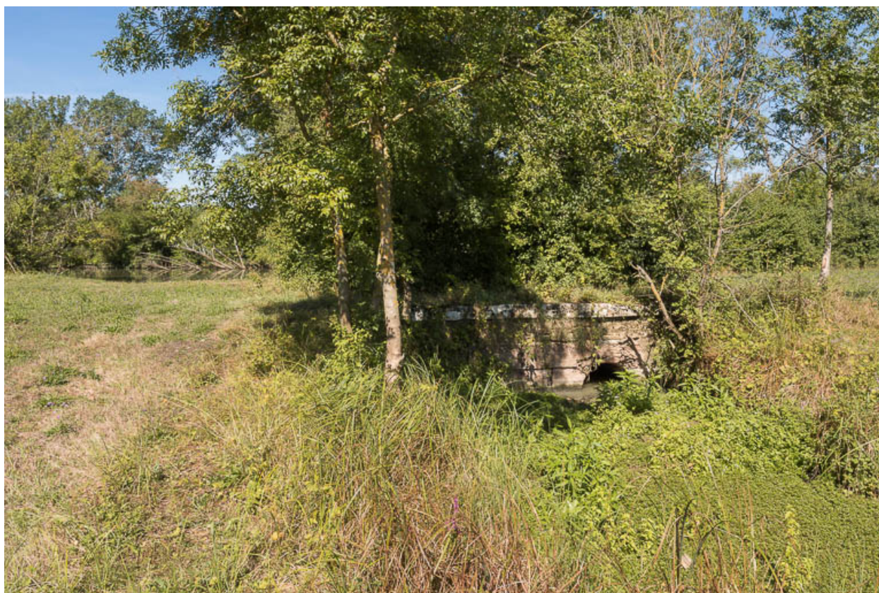
Vue du ponceau.
