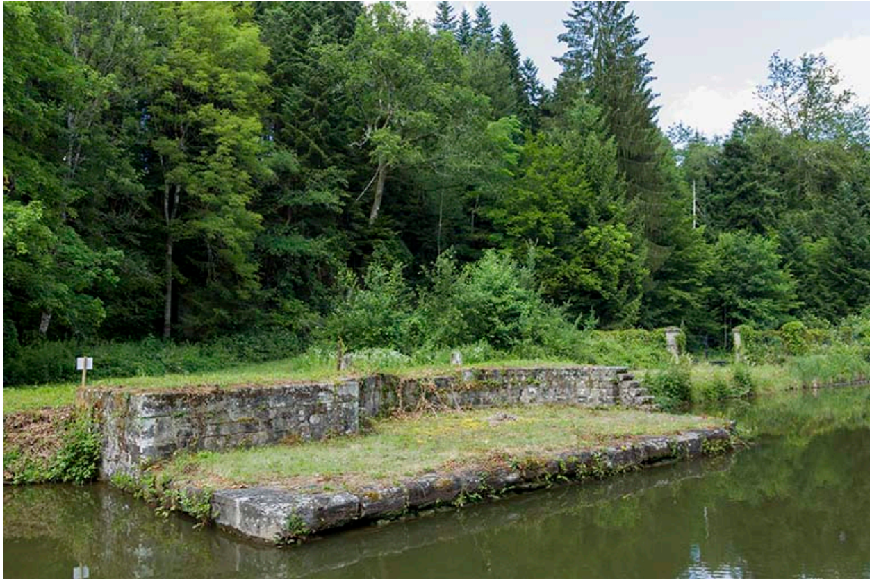
Emplacement du pont tournant au Fréland sur le canal de l'Est.
