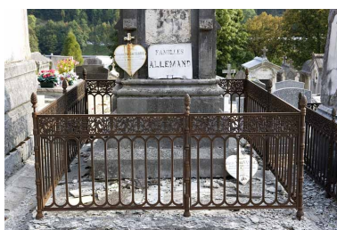
Vue d'ensemble, de la face antérieure. Phot. Yves Sancey IVR43_20093900071NUC2A
