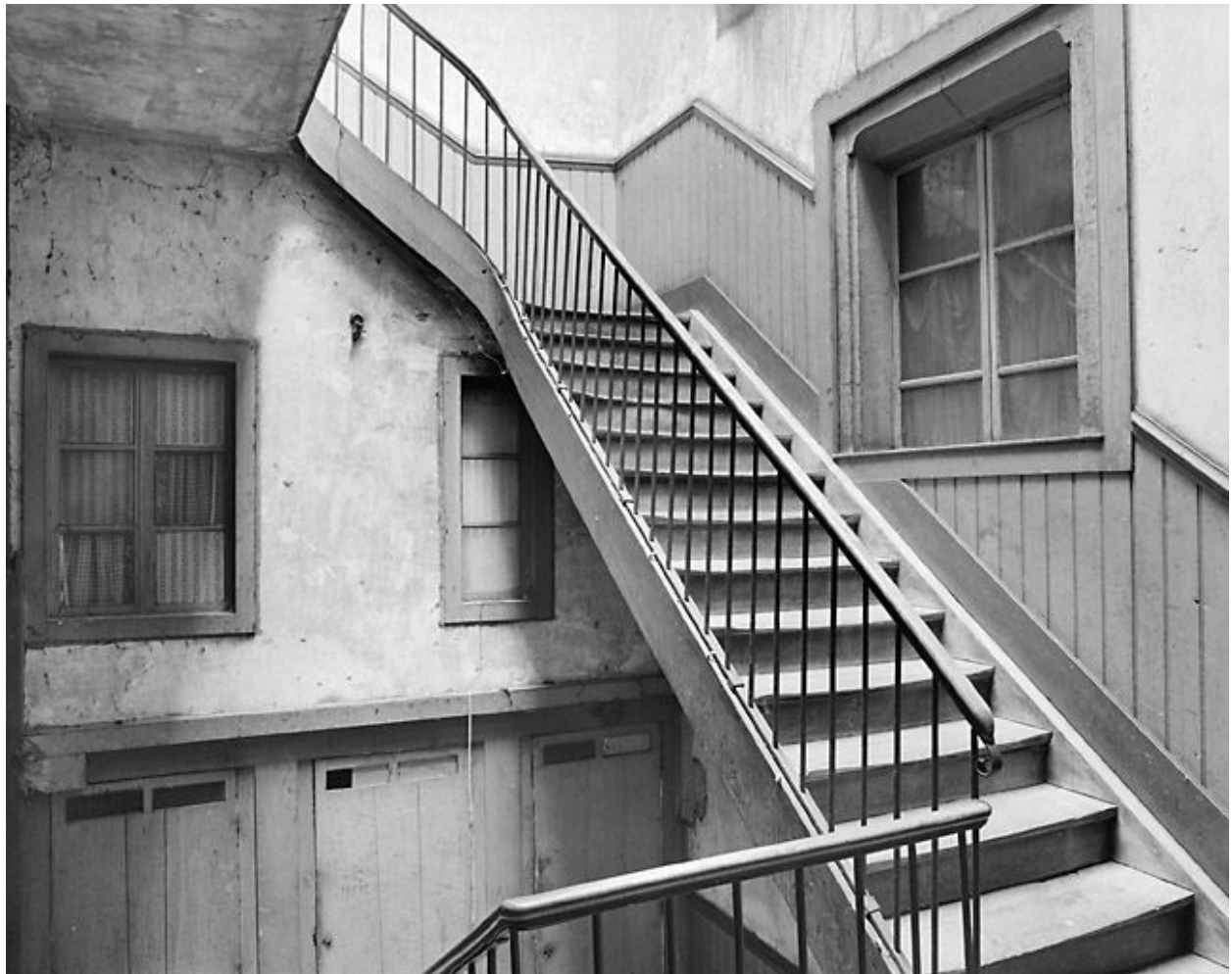
Escalier depuis le palier du premier étage.
