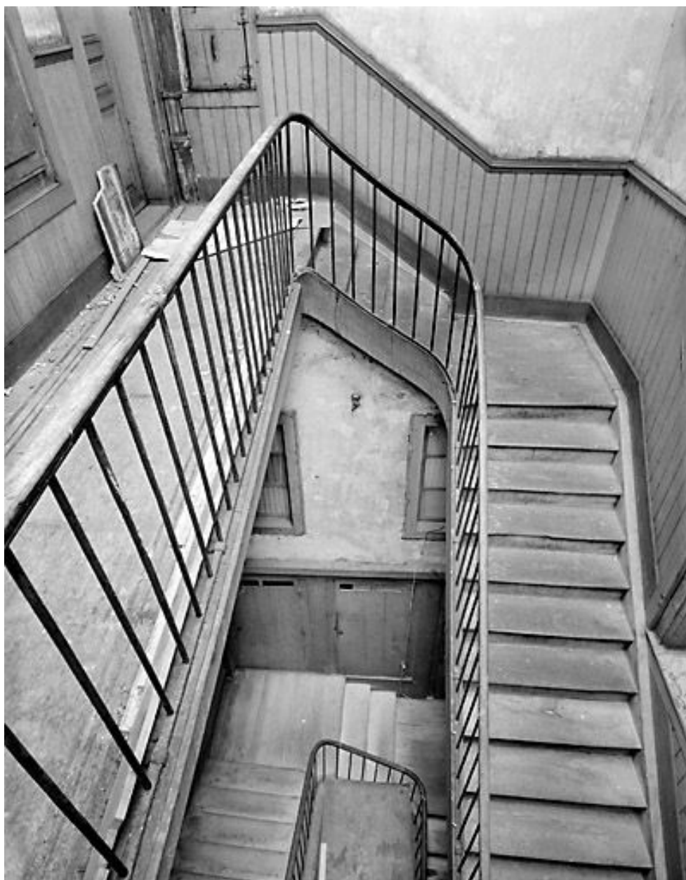
Vue plongeante sur la cage d'escalier.
