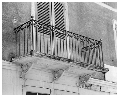
Balcon du corps de bâtiment occidental. Phot. Jérôme Mongreville IVR43_20003900376X
