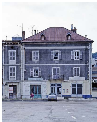
Le corps de bâtiment occidental.
