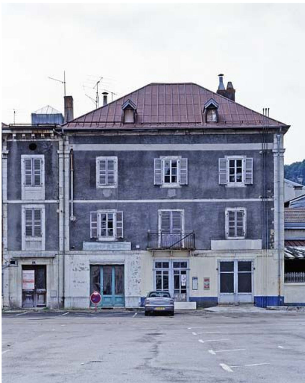
Le corps de bâtiment occidental.
