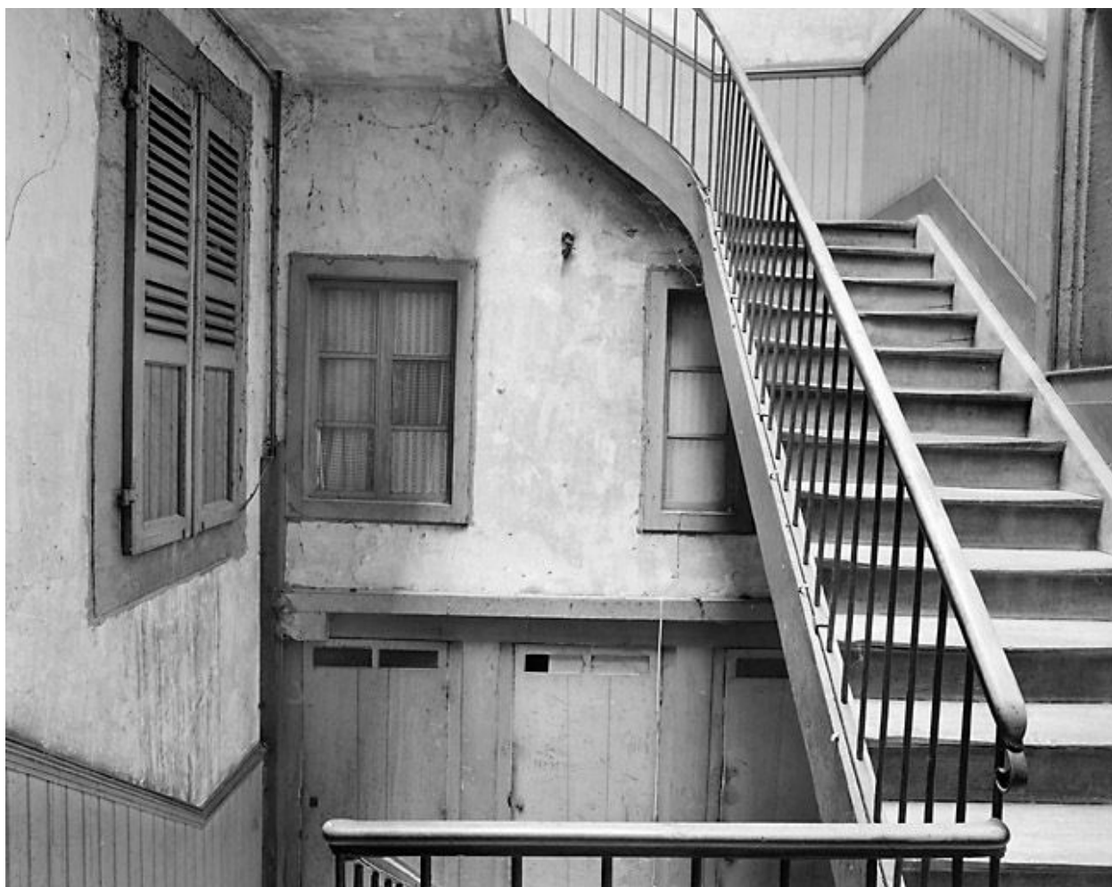
Cage d'escalier, au premier étage.
