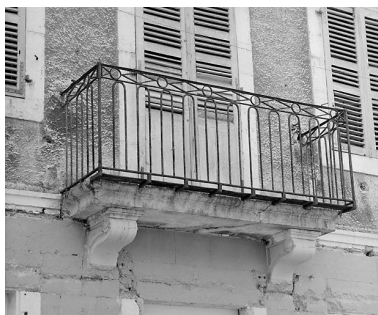
Balcon du corps de bâtiment oriental. Phot. Jérôme Mongreville IVR43_20003900377X
