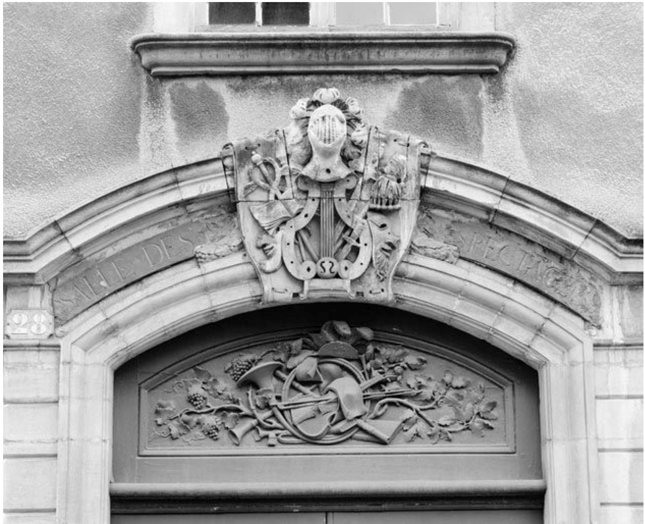
Façade antérieure en 1987 : détail du portail.
