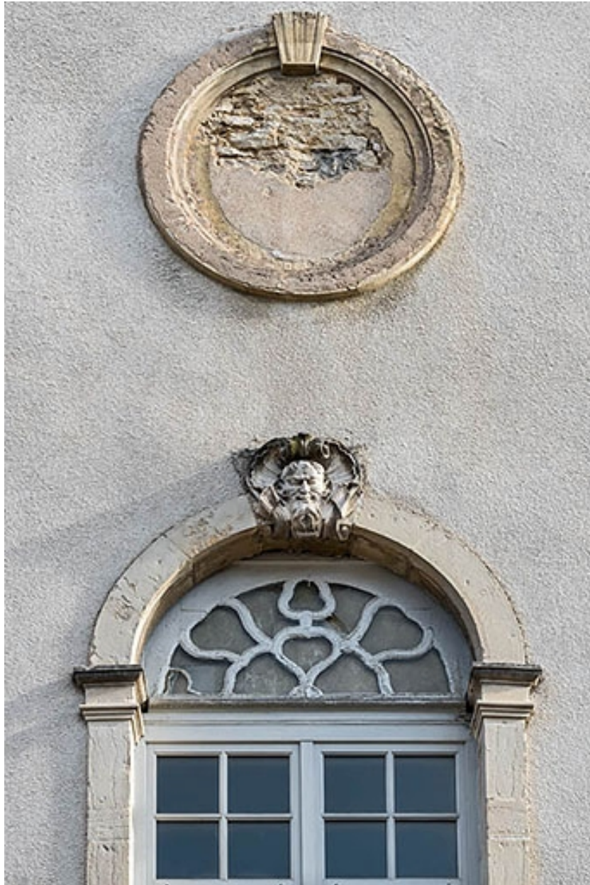
Façade antérieure, travée centrale : baies supérieures.
