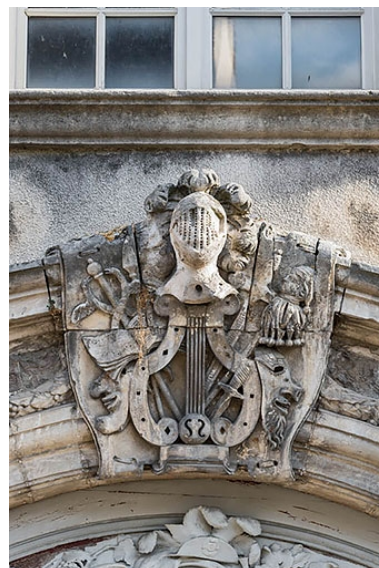
Façade antérieure, portail : claf sculptée. Phot. Pierre-Marie Barbe-Richaud IVR26_20212100222NUC4A
