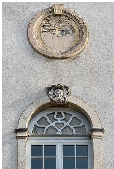
Façade antérieure, travée centrale : baies supérieures. Phot. Pierre-Marie Barbe-Richaud IVR26_20212100224NUC4A
