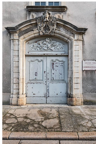
Façade antérieure : portail. Phot. Pierre-Marie Barbe-Richaud IVR26_20212100221NUC4A
