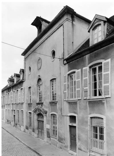
Façade antérieure en 1987. Phot. Jean-Luc Duthu IVR26_19872101196V
