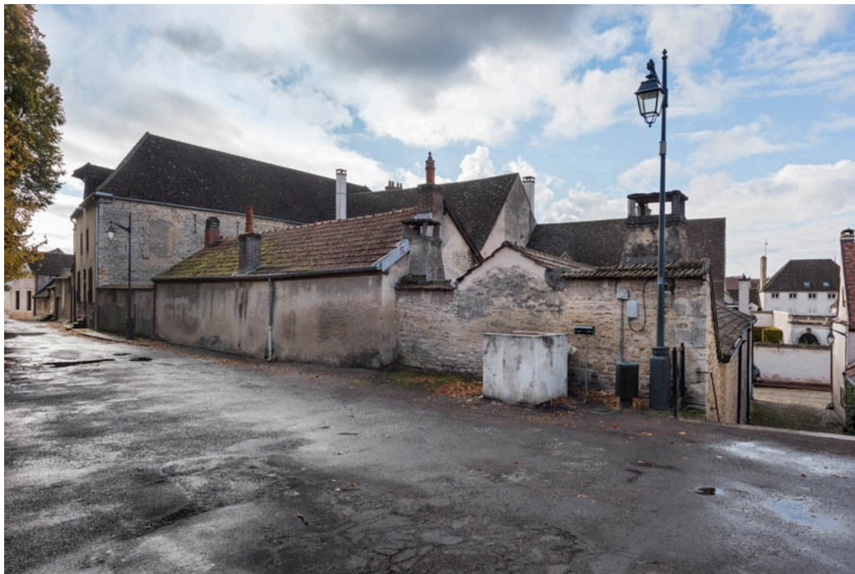
Vue d'ensemble côté rempart de la Comédie, depuis le nord-ouest.
