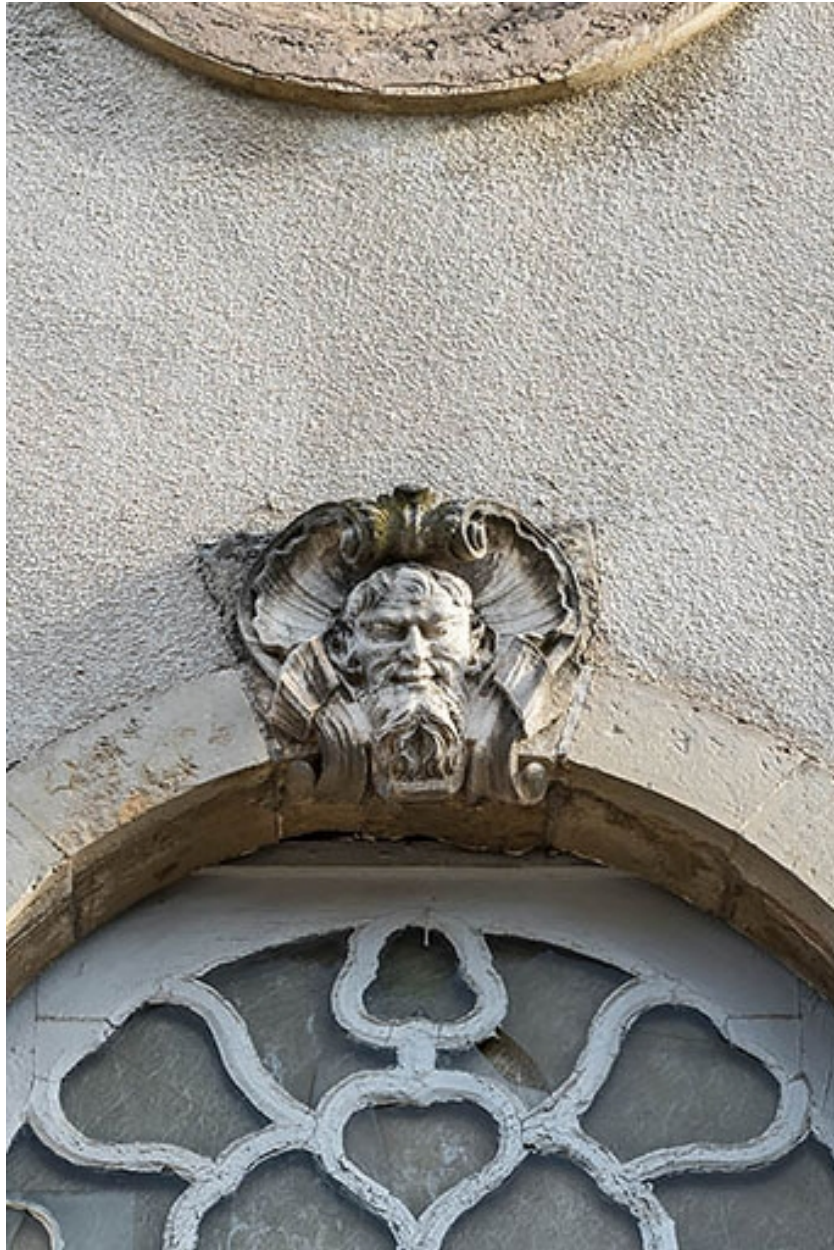
Façade antérieure, travée centrale : clef sculptée de la fenêtre.
