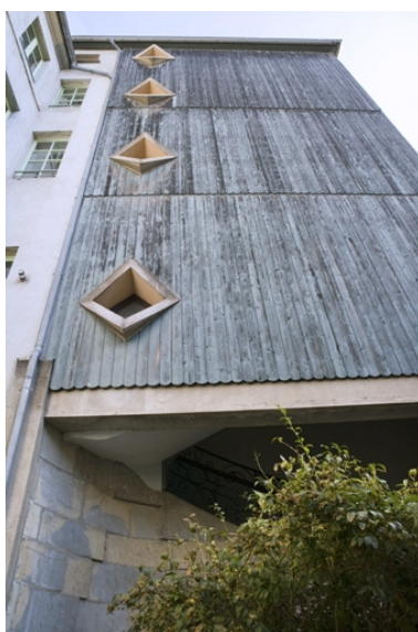
Escalier à cage ouverte sur cour : détail de la fermeture de la cage. Phot. Yves Sancey IVR43_20092501448NUC2A
