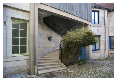
Détail du départ de l'escalier à cage ouverte sur cour. Phot. Yves Sancey IVR43_20092501446NUC2A
