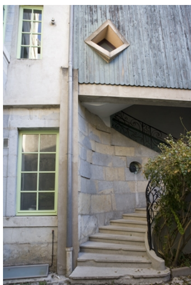
Détail du départ de l'escalier à cage ouverte sur cour, vue verticale. Phot. Yves Sancey IVR43_20092501447NUC2A
