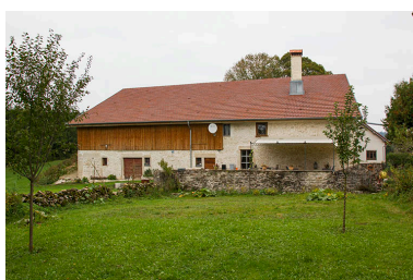
Façade latérale gauche. Phot. Yves Sancey IVR43_20132501688NUC2A
