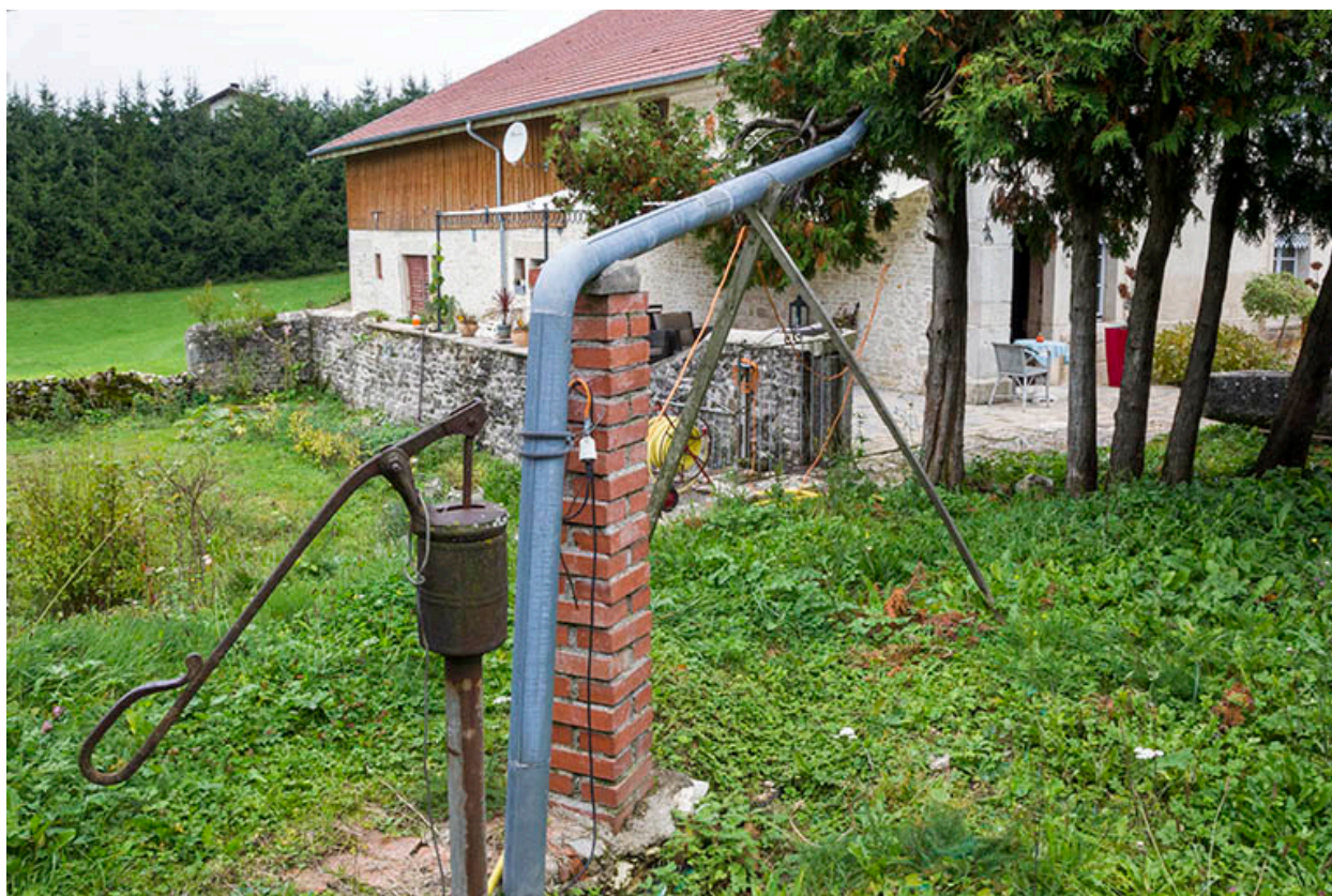
Citerne, pompe et tuyau d'amenée d'eau.
