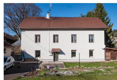
Atelier de fabrication (au n° 6) : façade antérieure.
