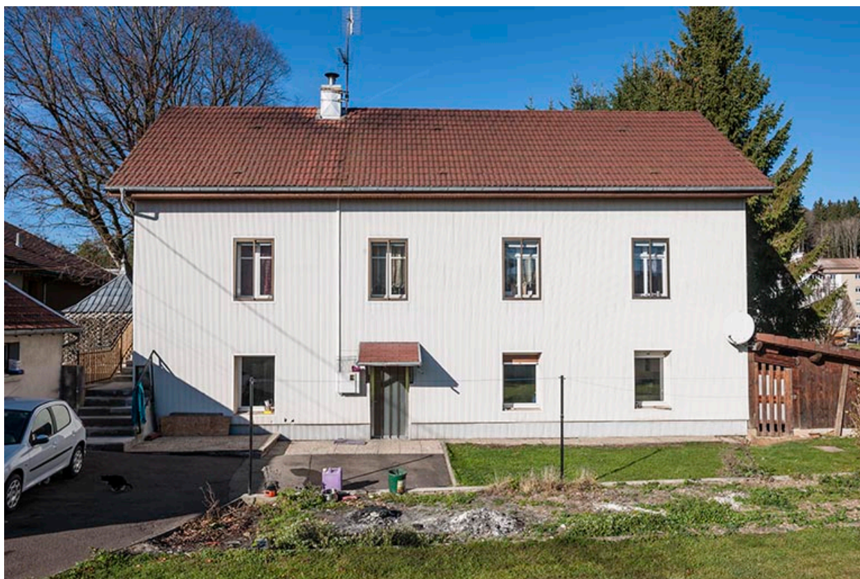
Atelier de fabrication (au n° 6) : façade antérieure.
