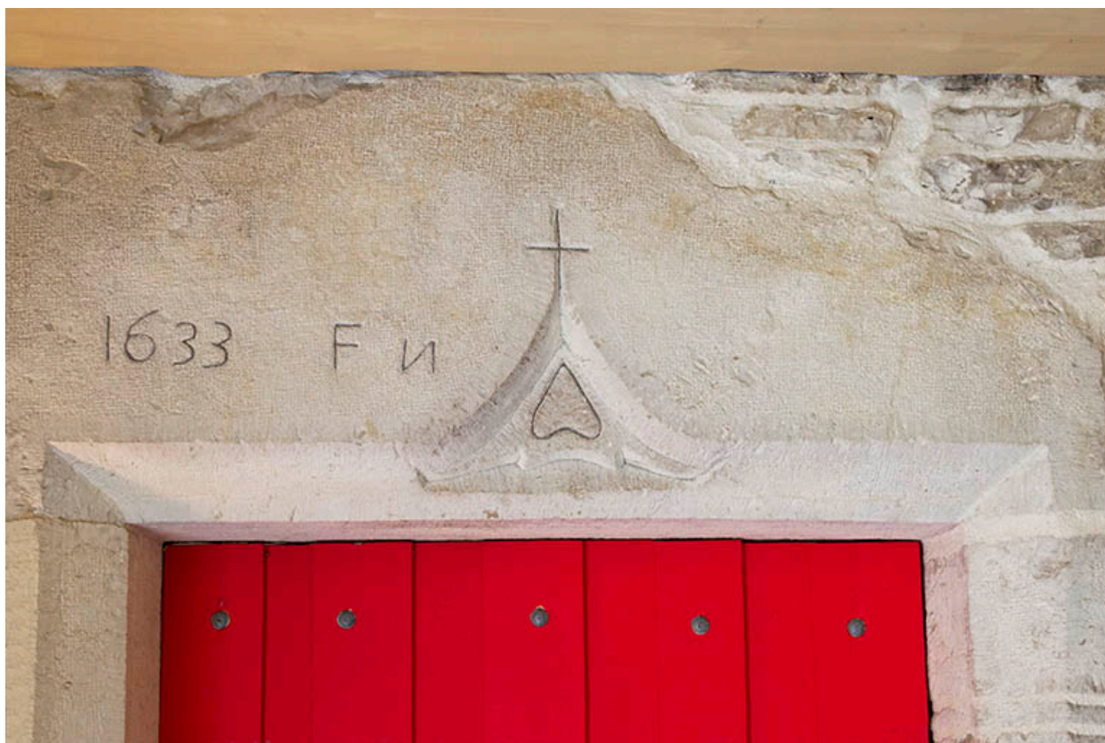
Linteau portant la date 1633, intégré au bâtiment.
