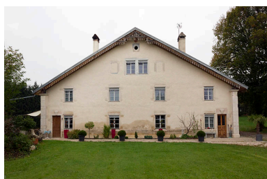
Façade antérieure. Phot. Yves Sancey IVR43_20132501685NUC2A
