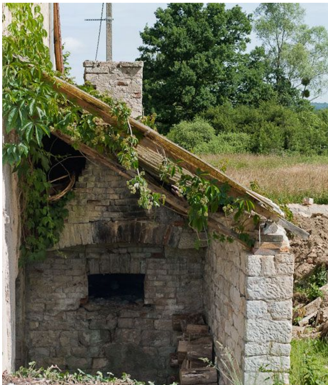
Vue du four à pain.
