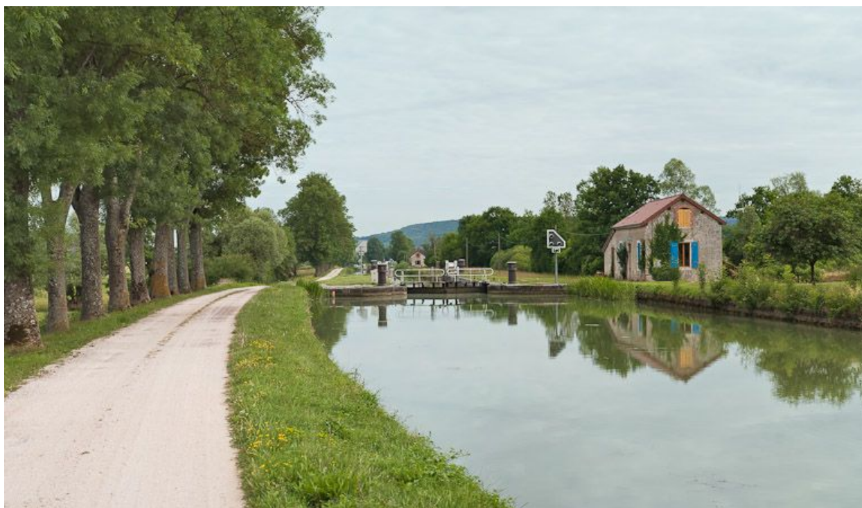
Vue d'ensemble du site d'écluse.
