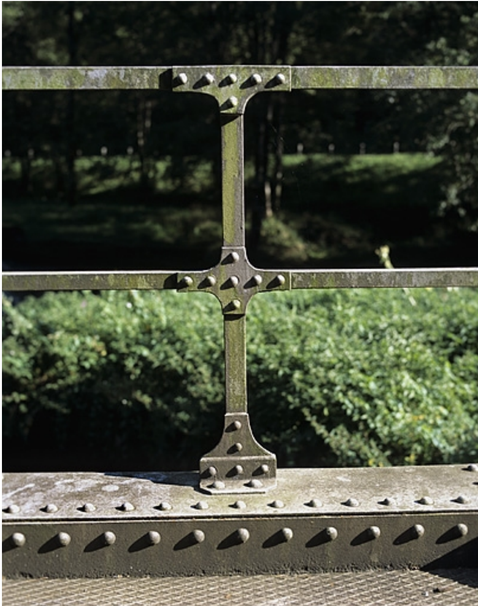
Pont : détail du garde-corps.
