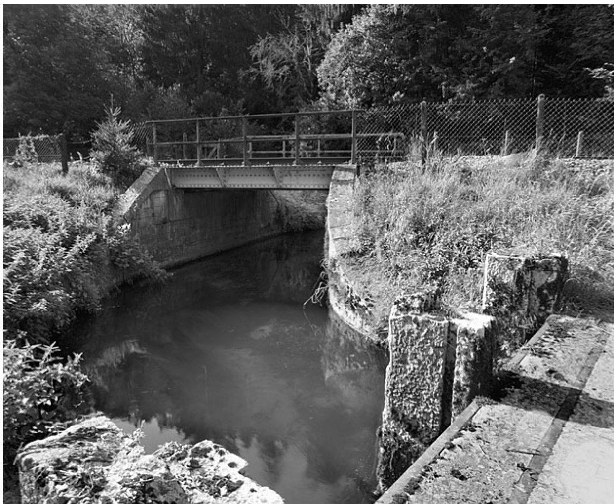
Vue d'ensemble, depuis le système de vannage à l'est.
