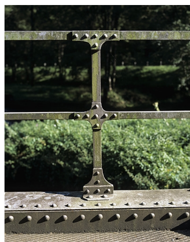
Pont : détail du garde-corps.
