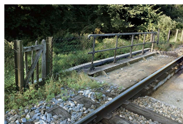
Vue d'ensemble, depuis la voie côté La Cluse (sud-ouest). Phot. Yves Sancey IVR43_20050100116ZA
