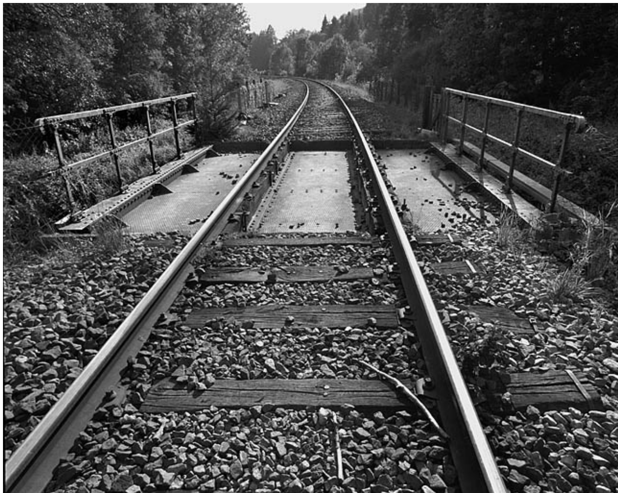
Vue d'ensemble, depuis la voie côté Andelot-en-Montagne (nord-est).
