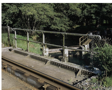
Pont : garde-corps. À l'arrière-plan, prise d'eau et vannage.
