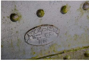
Pont : plaque du constructeur. Phot. Yves Sancey IVR43_20070100019NUCA
