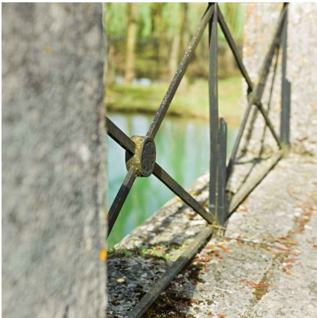
Détail du garde-corps.
