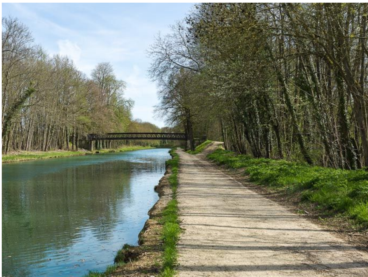
Vue d'ensemble du pont.
