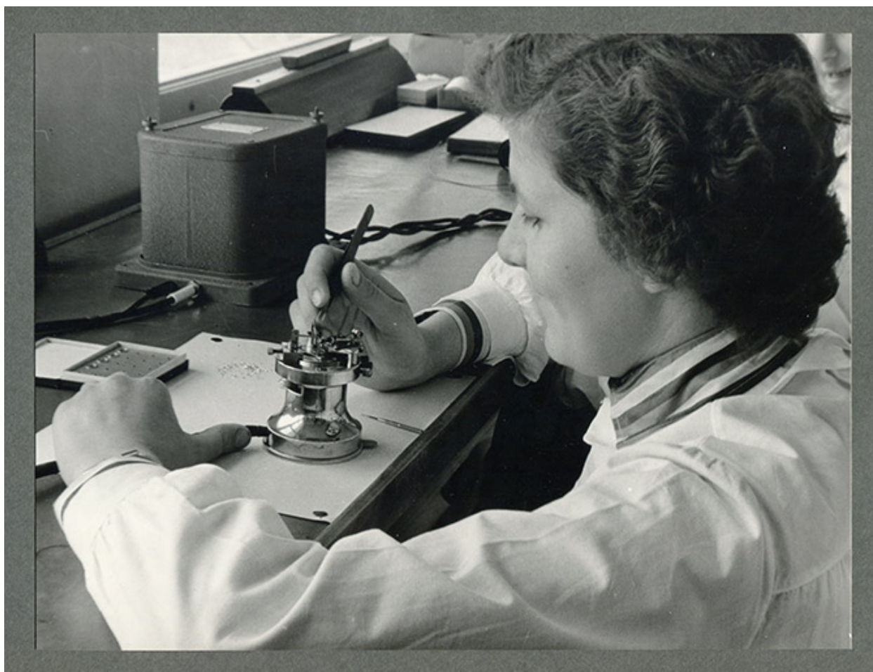
Ouvrière au travail : réglage du balancier-spiral, années 1960.
