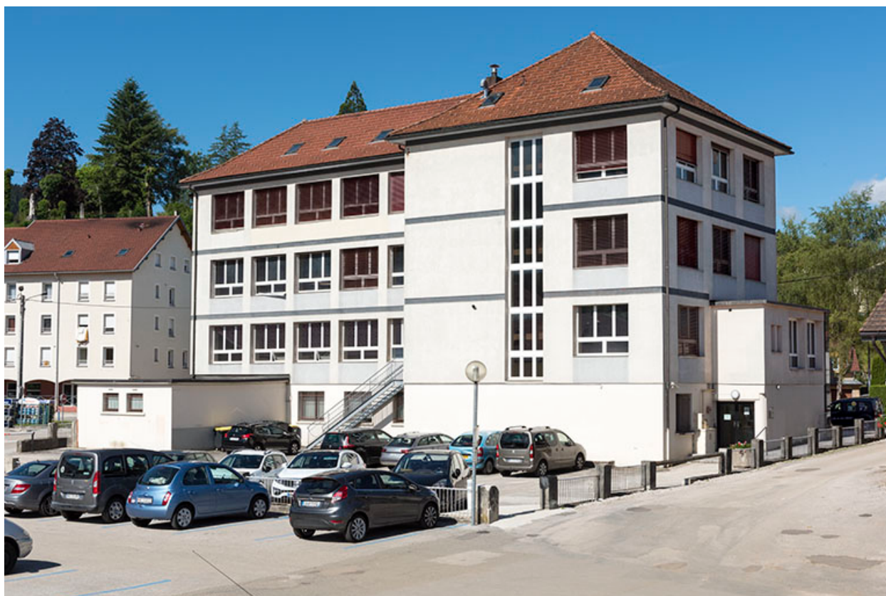
Façades postérieure et latérale gauche.
