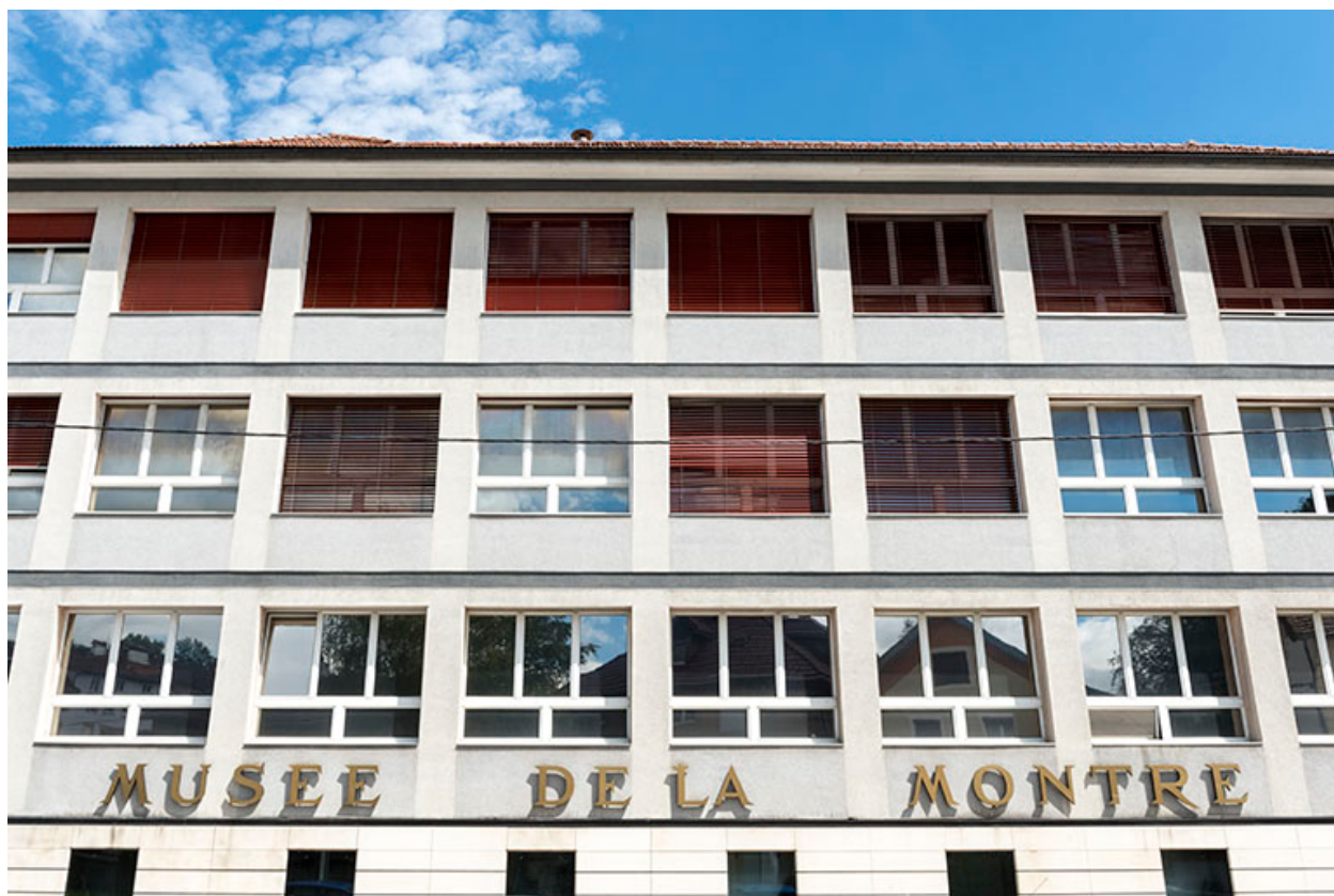
Façade antérieure, vue en contre-plongée.
