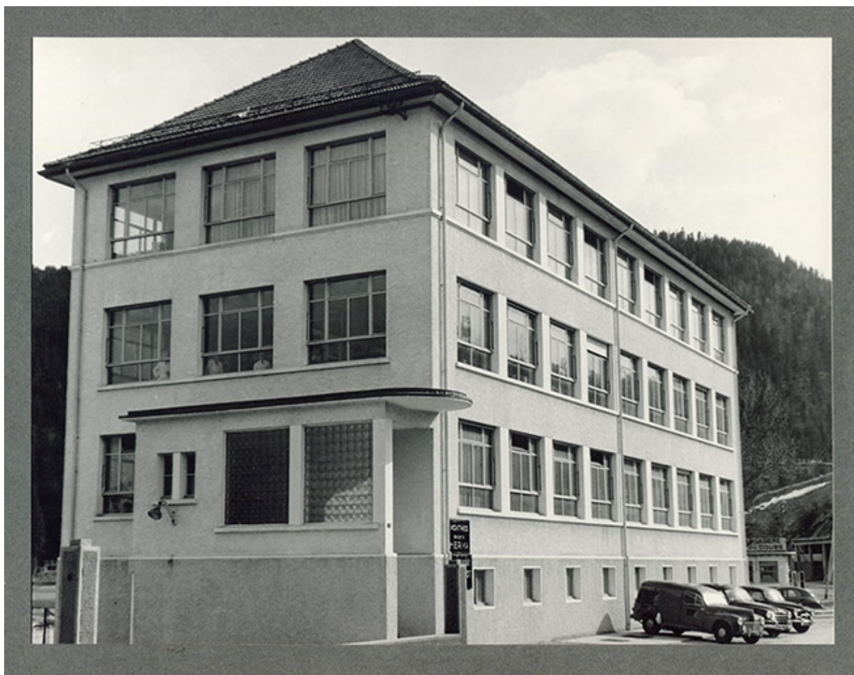
Façades antérieure et latérale gauche, années 1960.
