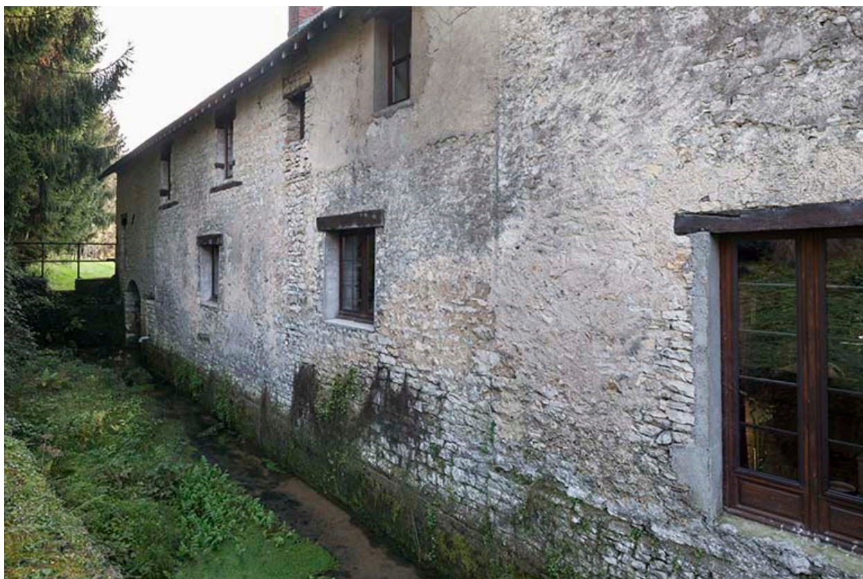
Façade est de l'atelier de forge.
