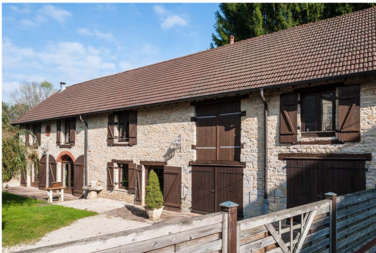
Bâtiment de la forge. Façade ouest.
