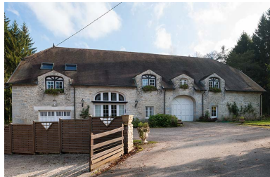
Bâtiment du moulin. Façade nord. Phot. Jérôme Mongreville IVR43_20142501582NUC4A
