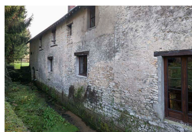
Façade est de l'atelier de forge. Phot. Jérôme Mongreville IVR43_20142501586NUC4A
