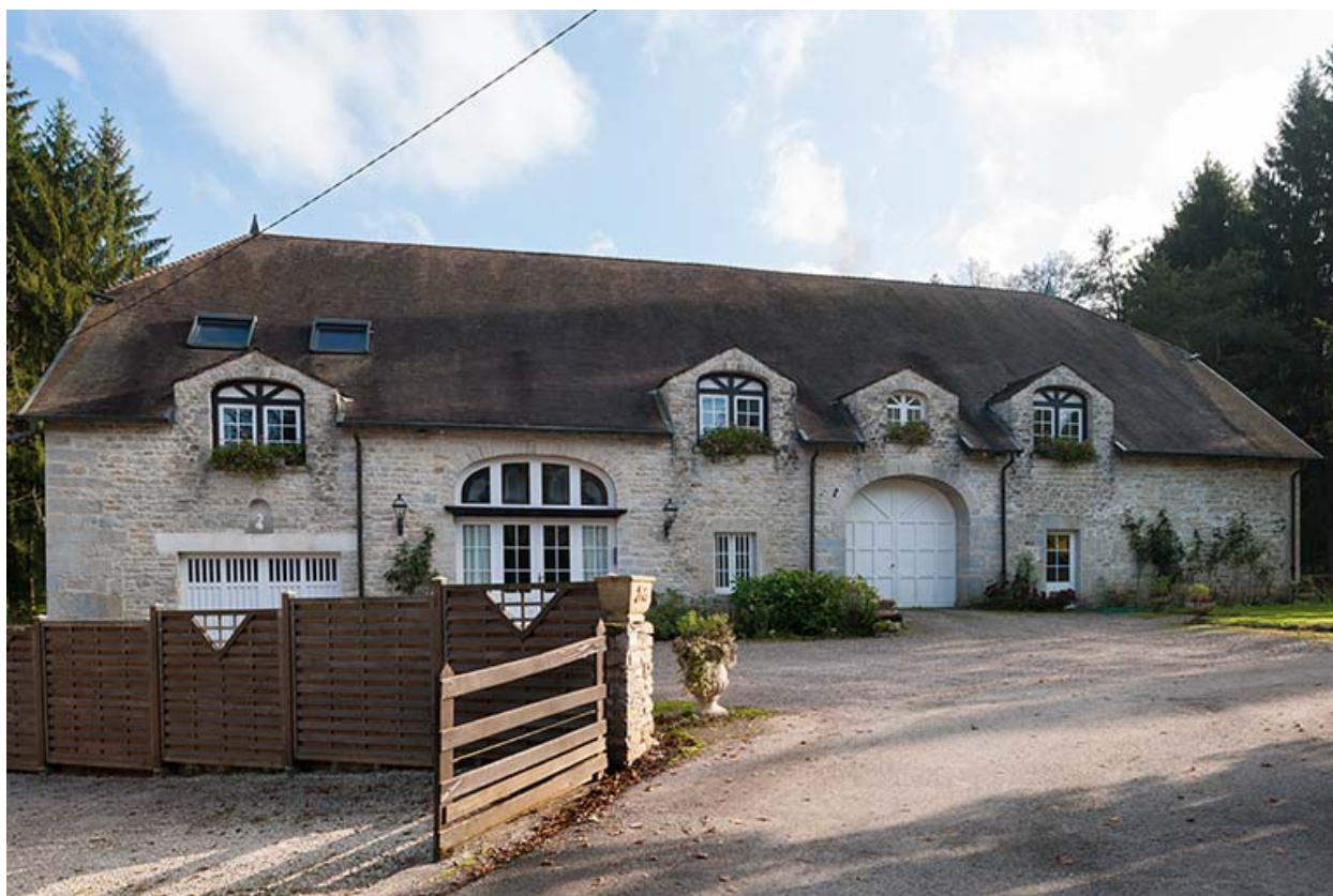
Bâtiment du moulin. Façade nord.
