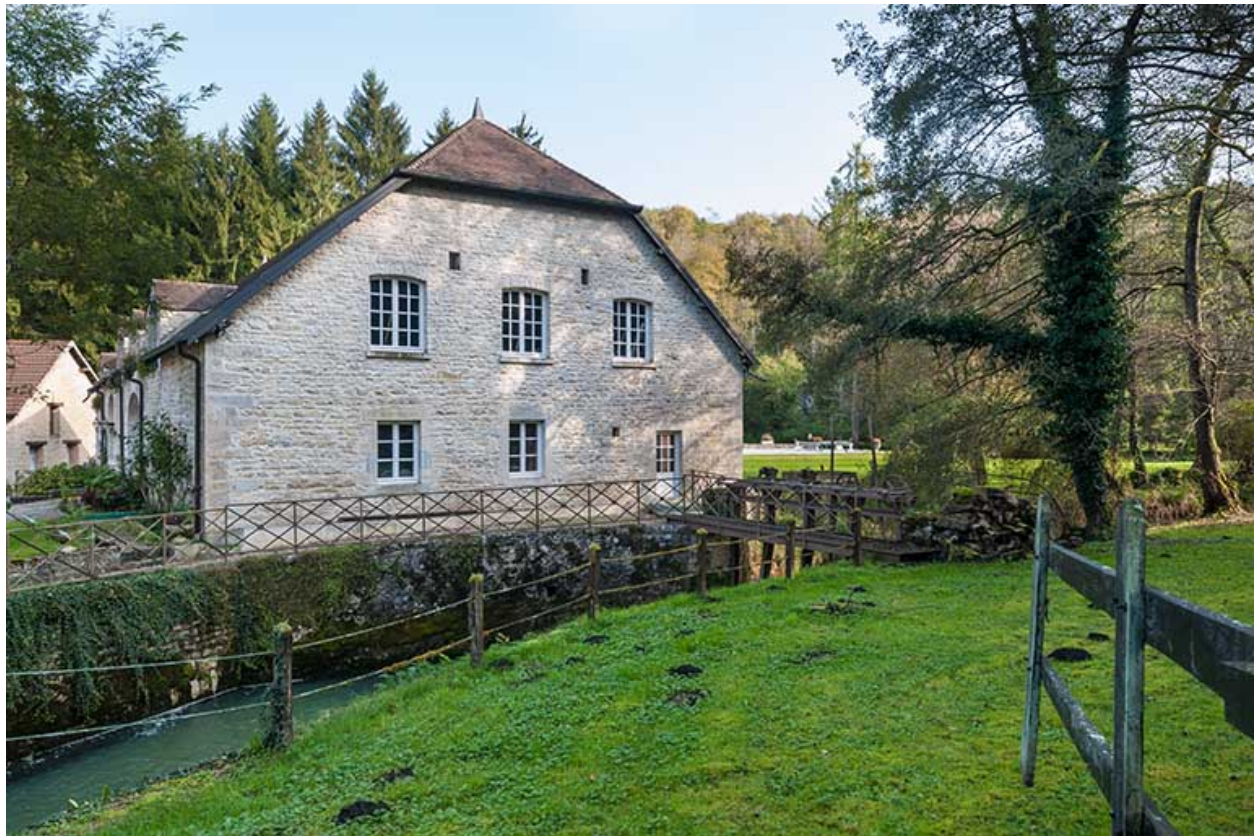
Pignon du moulin.
