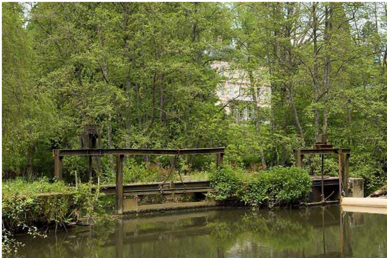
Vannage sur le bief d'amenée.
