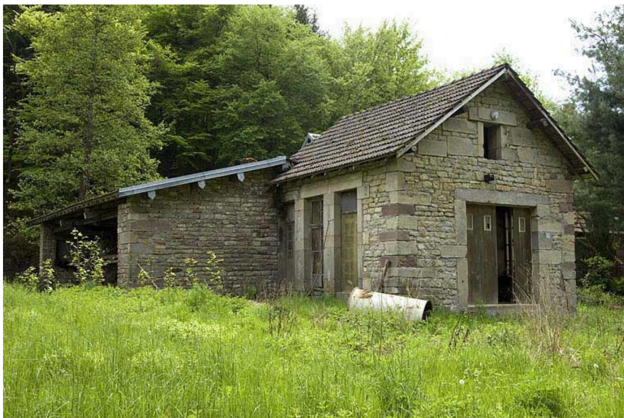
Bâtiment d'eau (local des turbines).
