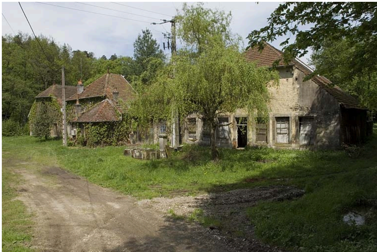
Façades antérieures depuis le sud.
