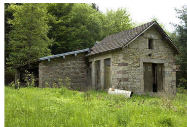
Bâtiment d'eau (local des turbines).
