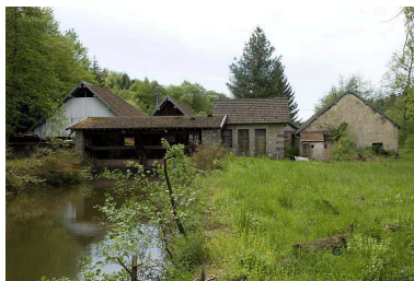
Façades postérieures depuis le bief d'amenée.
