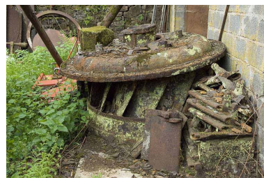
Vestiges d'une turbine Francis.
