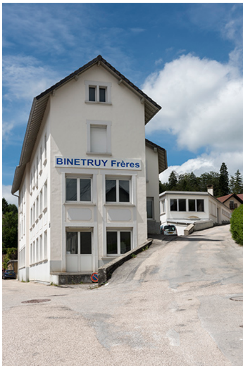
Bâtiments rue de l'Horlogerie : façade latérale est.
