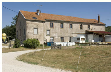
Façade occidentale. Phot. Jérôme Mongreville IVR43_20067000645NUCA
