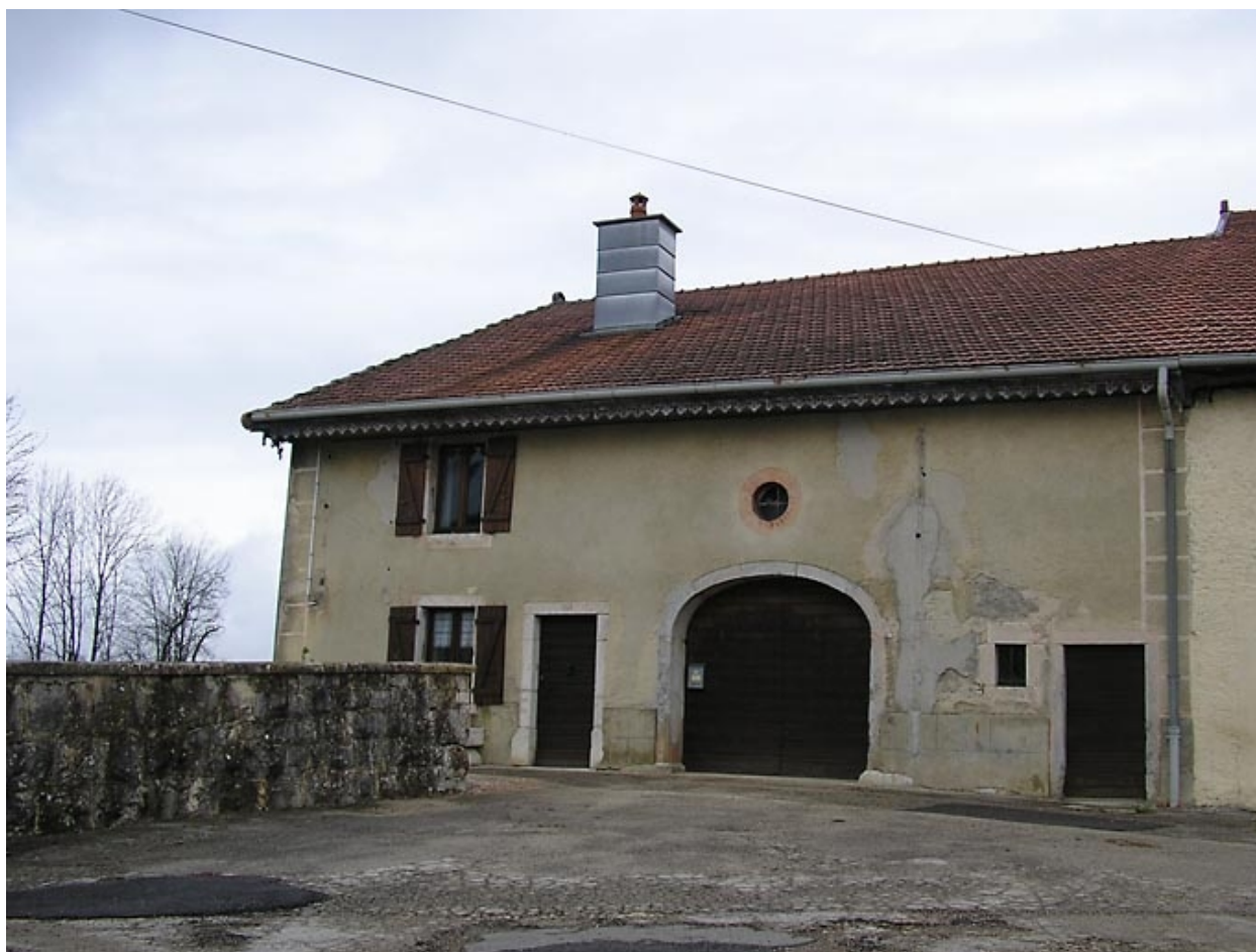
Vue générale de la façade postérieure.
