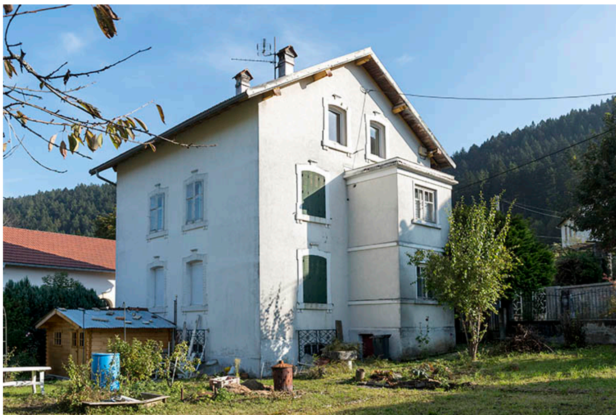
Façades postérieure et latérale gauche.
