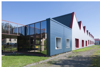
Façade sud de l'atelier de fabrication.
