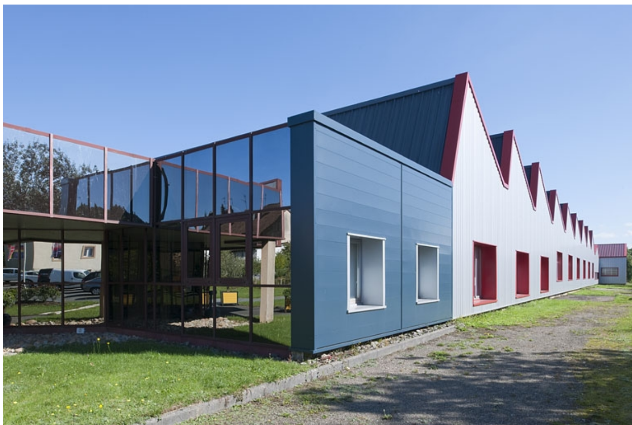
Façade sud de l'atelier de fabrication.
