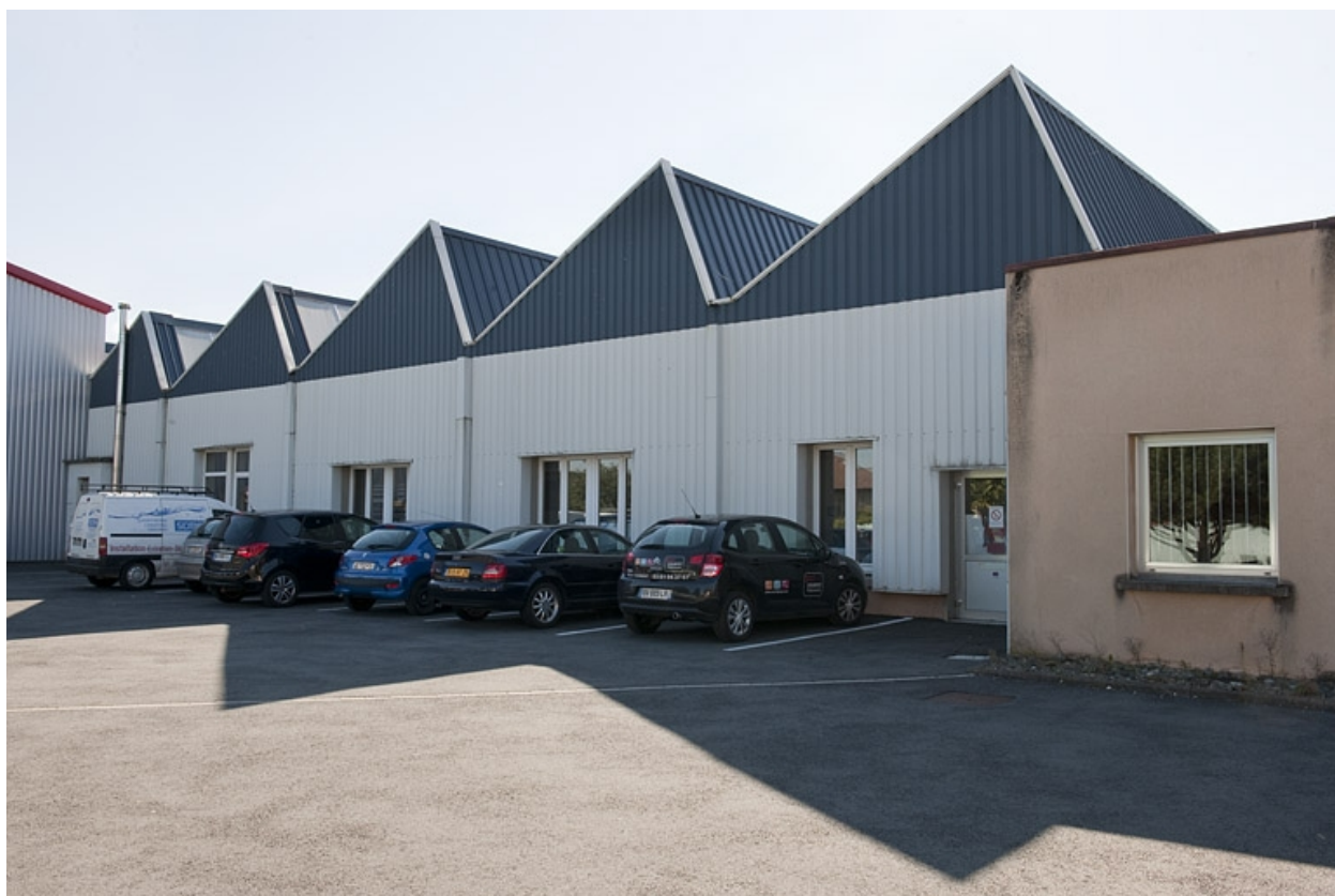
Bardage de la façade nord.
