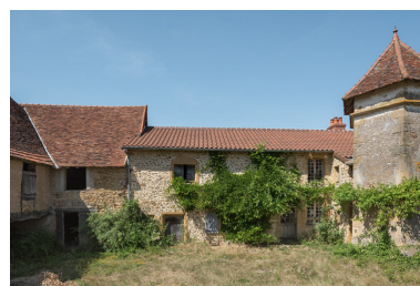
Vue de l'ensemble des bâtiments fermant la cour au nord. De gauche à droite, un bâtiment agricole avec son toit pentu, abritant une étable et un fenil, et la maison avec sa tour d'escalier hexagonale hors-oeuvre. Phot. Pierre-Marie Barbe-Richaud IVR26_20197100199NUC4A
