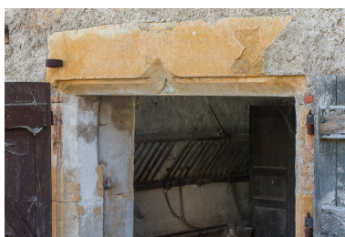
Porte de l'étable double. Le bâtiment étant vraisemblablement plus récent que l'habitation, le linteau avec son accolade est probablement ici un remploi. Phot. Pierre-Marie Barbe-Richaud IVR26_20197100207NUC4A
