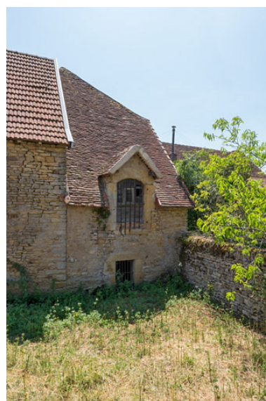
Cette façade, à l'extrémité de l'aile de dépendance du XVIII e siècle, est percée d'une lucarne pendante qui éclaire le cellier, aménagé au-dessus d'une cave, dans la continuité du hangar à bois. Phot. Pierre-Marie Barbe-Richaud IVR26_20197100185NUC4A
