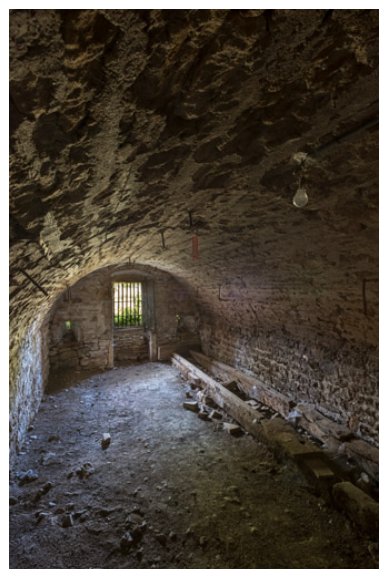
Vue intérieure de la cave Phot. Pierre-Marie Barbe-Richaud IVR26_20197100206NUC4A
