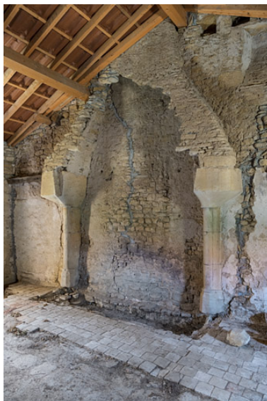
Cheminée, partiellement démantelée dans une grande chambre à l'étage, qui fut peut-être utilisée en remploi comme pourrait l'indiquer sa taille disproportionnée par rapport à la pièce, à moins que le toit n'ait été plus haut à l'origine. Phot. Pierre-Marie Barbe-Richaud IVR26_20197100193NUC4A
