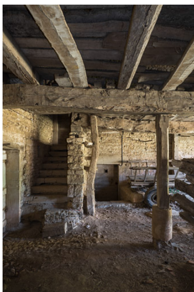
Hangar à droite de la remise. Au fond, deux petits escaliers permettent l'accès à un cellier pour l'un et à une cave semi-enterrée pour le second. Phot. Pierre-Marie Barbe-Richaud IVR26_20197100203NUC4A
