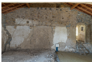
Mur de la grande chambre, face à la cheminée. Les trous marquant l'emplacement d'anciennes poutres et la hauteur de l'enduit à la chaux, qui recouvre le mur, indique la présence d'un ancien plancher, qui séparait la pièce des combles. Phot. Pierre-Marie Barbe-Richaud IVR26_20197100195NUC4A
