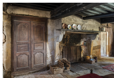
Vue de la cuisine, avec sa cheminée et un placard, aménagé dans l'épaisseur du mur. Phot. Pierre-Marie Barbe-Richaud IVR26_20197100186NUC4A
