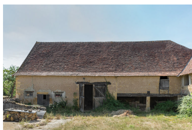
Aile de dépendance fermant la cour à l'ouest, vraisemblablement construit au XVIIIe siècle, abritant la grange (avec une étable double pour les bovins), un hangar, une cave et un grenier. Phot. Pierre-Marie Barbe-Richaud IVR26_20197100200NUC4A
