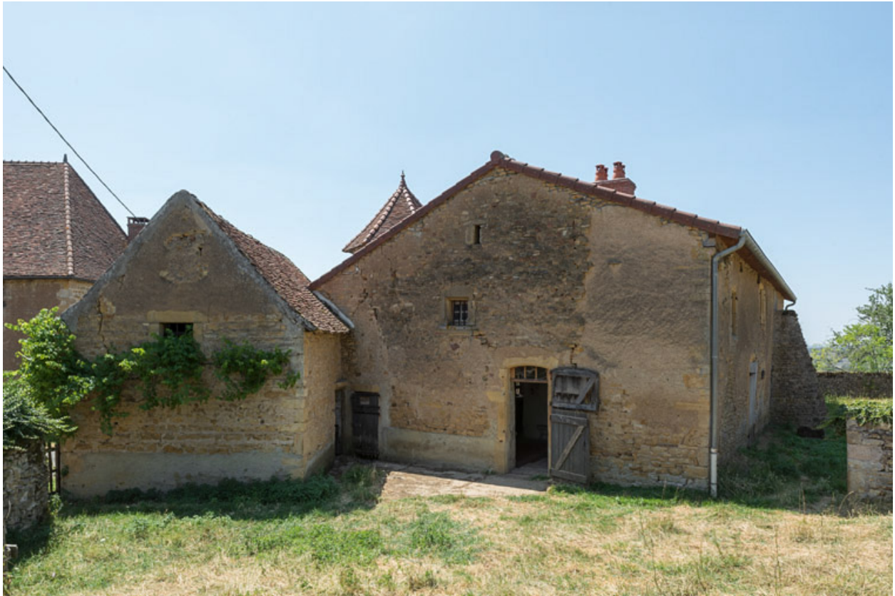
Mur-pignon est de la demeure joignant la petite écurie, fermant la cour de ferme à l'est
