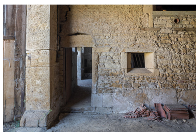
Intérieur de la remise, à côté de l'étable, présentant un des piédroits de l'ouverture de la porte (avec son chasse-roue) et une partie du mur mitoyen avec l'étable percé d'une porte et de feurons. Phot. Pierre-Marie Barbe-Richaud IVR26_20197100201NUC4A
