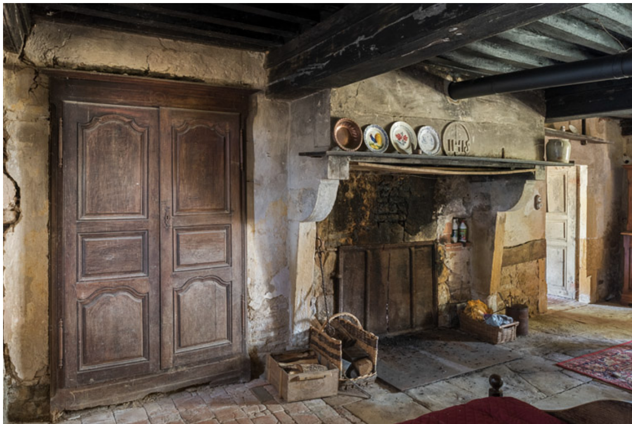
Vue de la cuisine, avec sa cheminée et un placard, aménagé dans l'épaisseur du mur.
