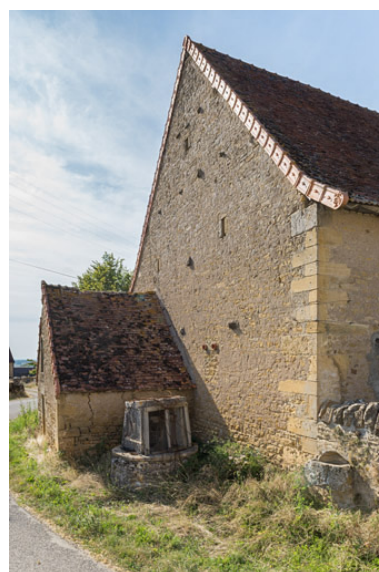
Petit bâtiment contre la grange et puits. A droite, un récipient en pierre est inclus dans le mur de clôture de la propriété et servait à remplir l'abreuvoir des animaux de l'autre côté du mur, avec l'eau du puits. Phot. Pierre-Marie Barbe-Richaud IVR26_20197100208NUC4A
