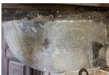
Corbeau portant le linteau de la cheminée et sur lequel est gravé une date - "18??" - indiquant une reprise de cet élément (et sans doute d'autres transformations) au XIXe siècle. Phot. Pierre-Marie Barbe-Richaud IVR26_20197100190NUC4A
