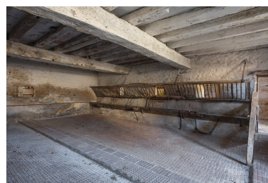
Vue intérieure de l'étable Phot. Pierre-Marie Barbe-Richaud IVR26_20197100202NUC4A
