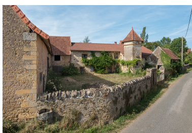
Vue d'ensemble des bâtiments du domaine Phot. Pierre-Marie Barbe-Richaud IVR26_20197100209NUC4A
