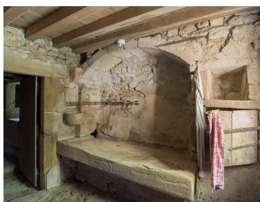
La bassie, avec sa pierre d'évier, dans une niche. Phot. Pierre-Marie Barbe-Richaud IVR26_20197100187NUC4AQ
