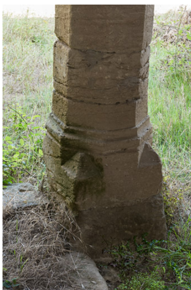
Une des poutres du plancher du fenil est soutenue par ce pilier hexagonal, avec une base moulurée, utilisé en remploi. Phot. Pierre-Marie Barbe-Richaud IVR26_20197100205NUC4A
