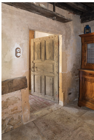
Porte au rez-de-chaussée de la demeure, entre la cuisine et une chambre. Son encadrement présente un chanfrein (angle abattu) qui se retrouve sur de nombreuses baies au rez-de-chaussée, comme à l'étage de l'habitation. Phot. Pierre-Marie Barbe-Richaud IVR26_20197100188NUC4A
