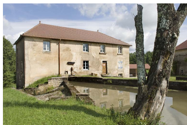
Façade sud du moulin. Phot. Jérôme Mongreville IVR43_20097000504NUC2A
