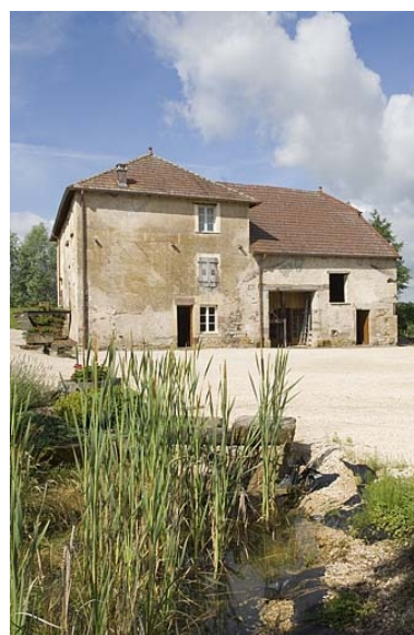
Le moulin depuis l'est. Phot. Jérôme Mongreville IVR43_20097000500NUC2A
