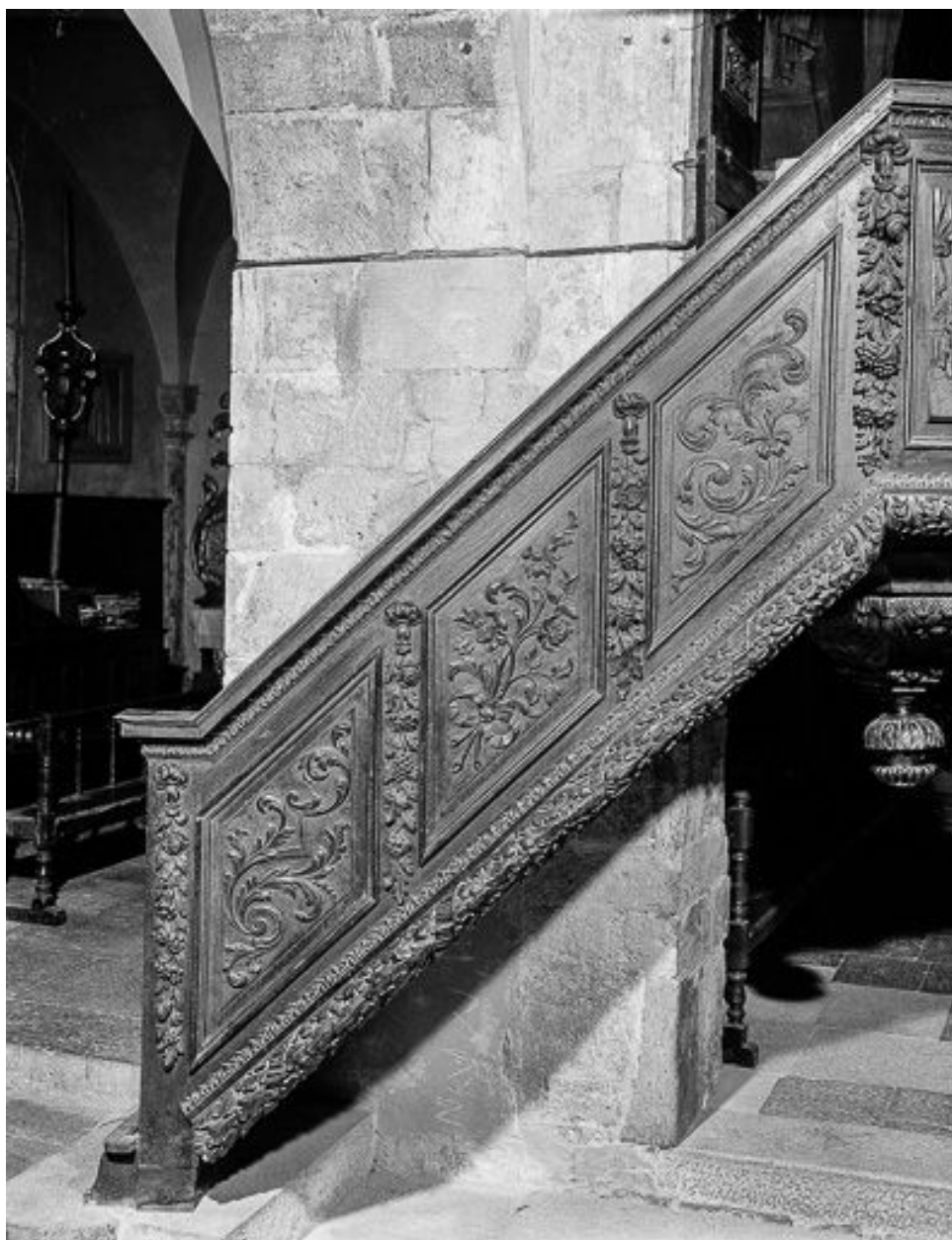
Vue générale de la rampe.
