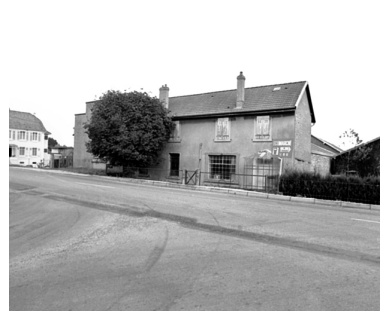
Bureau et logement. Phot. Yves Sancey IVR43_19999000408X
