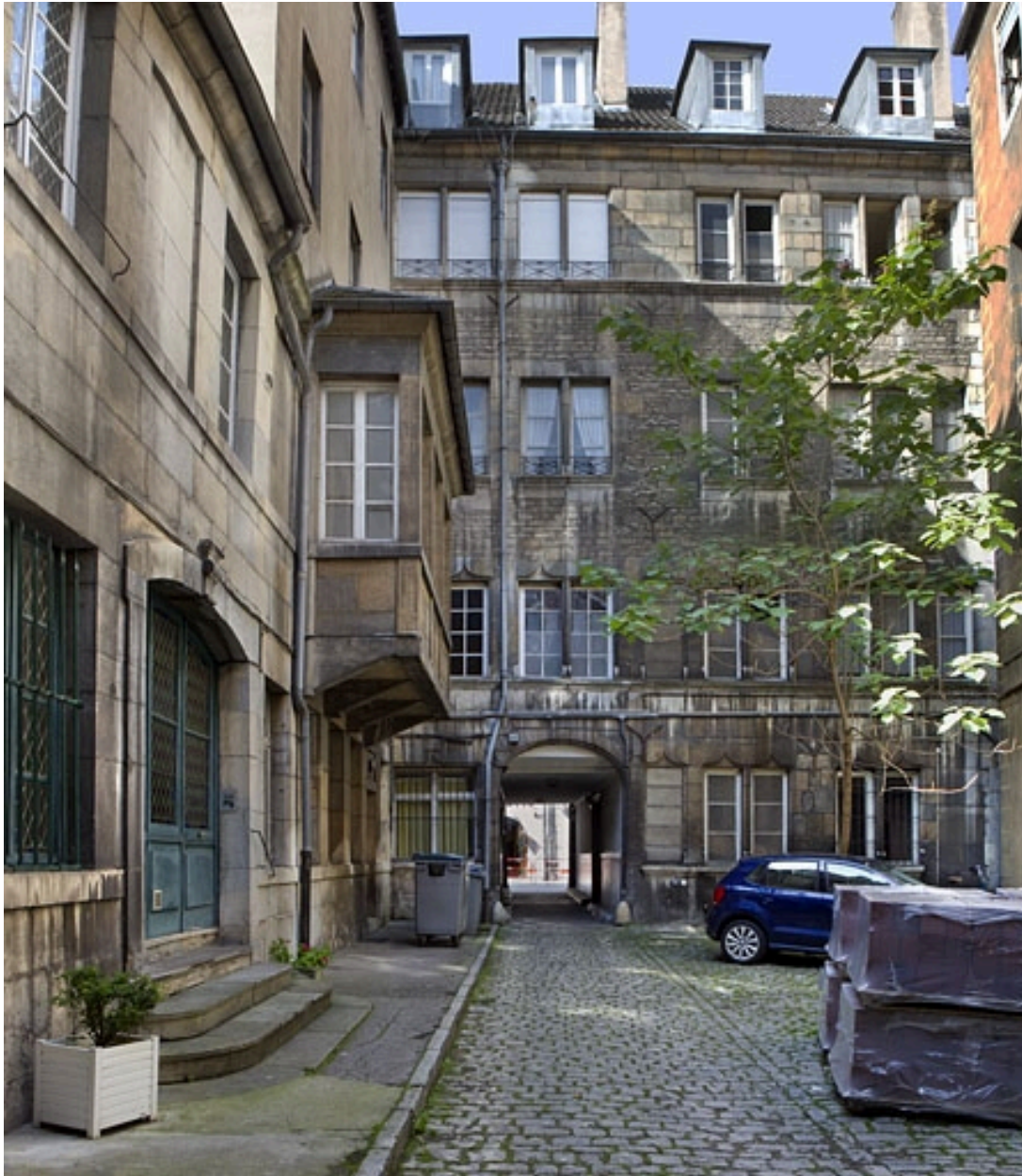
Façade postérieure sur cour de l'immeuble : vue d'ensemble de face.
