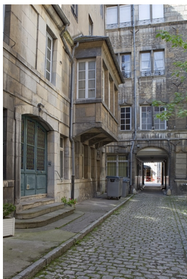
Vue des façades de l'immeuble depuis le fond de la cour, avec le bow-window.
