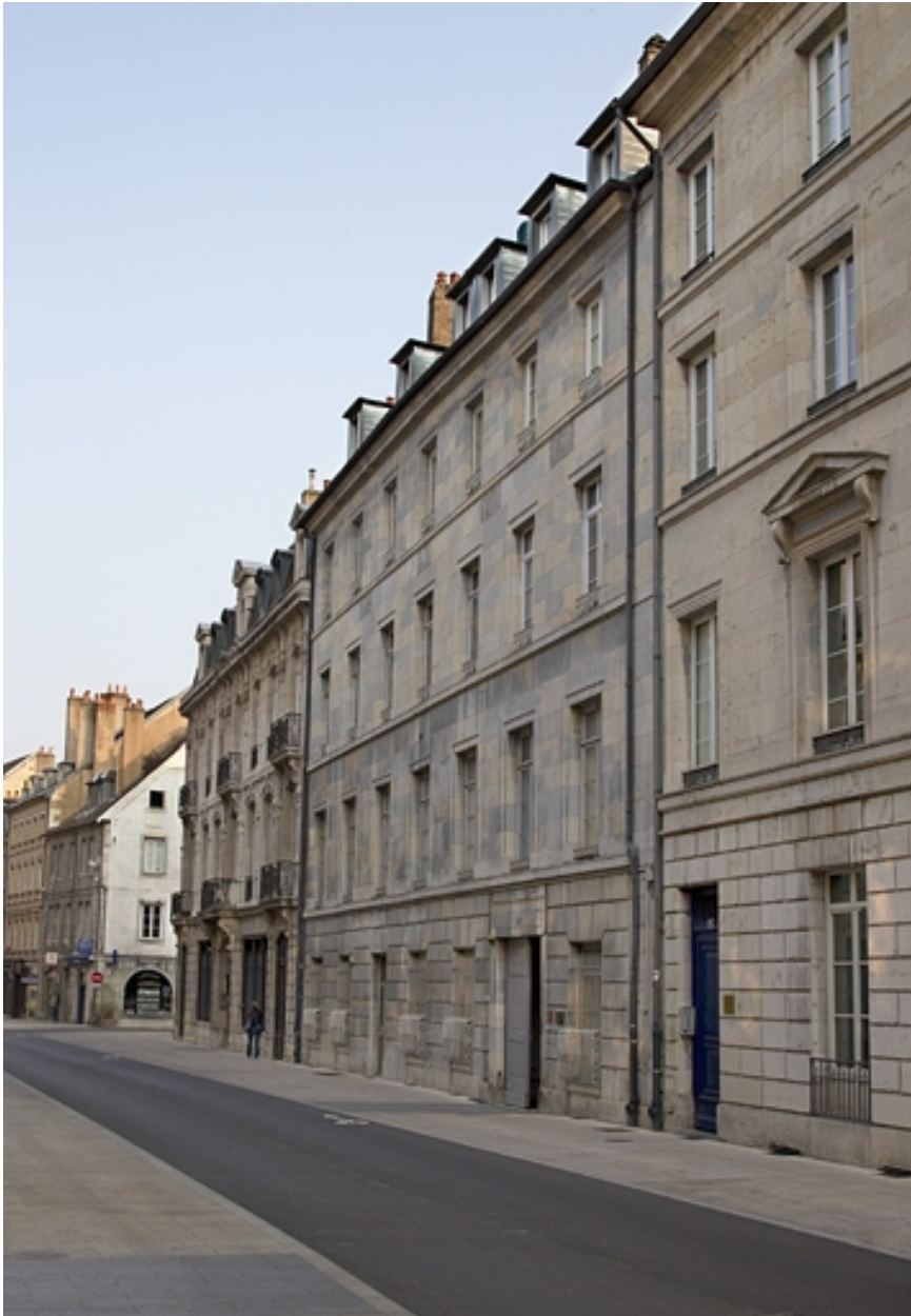
Vue d'ensemble de la façade antérieure de l'immeuble depuis la rue, de trois quarts droit.
