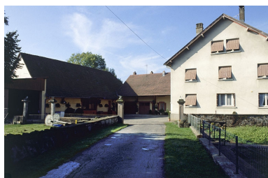
La minoterie depuis l'est. Phot. Yves Sancey IVR43_19999000147ZA
