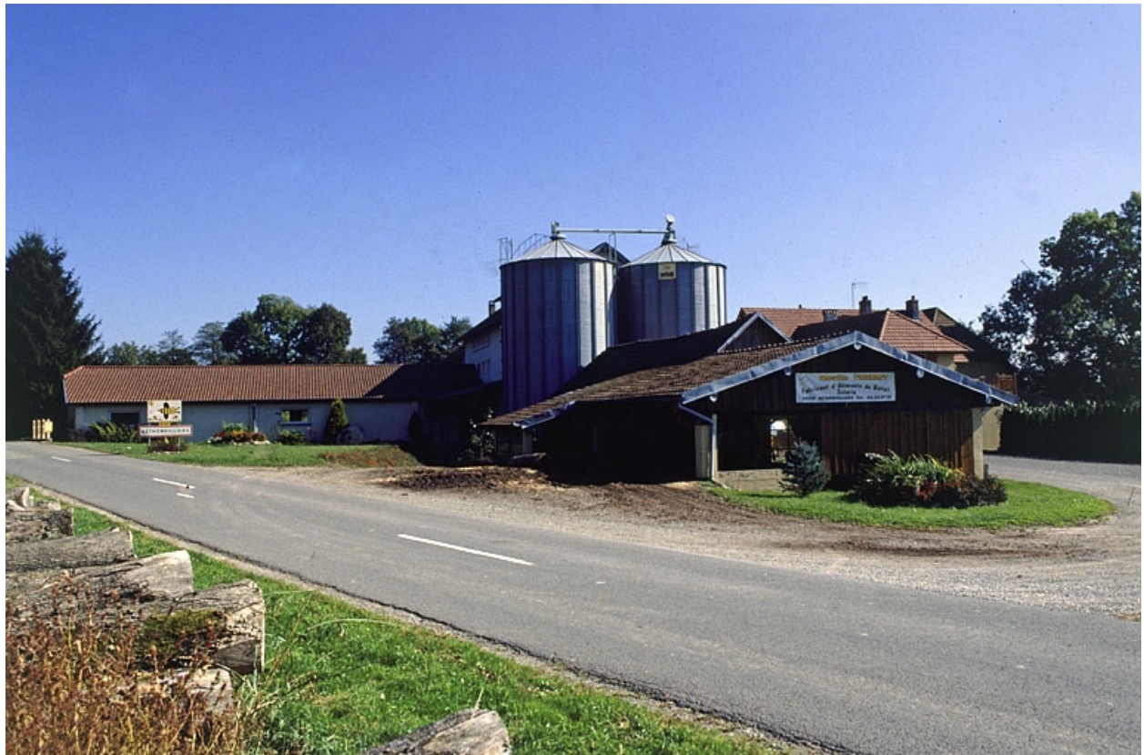
Magasin industriel, silos et scierie depuis l'ouest.
