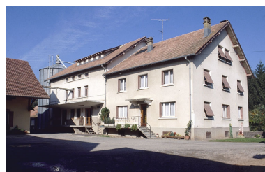
Atelier de fabrication (minoterie) et logement. Phot. Yves Sancey IVR43_19999000145ZA
