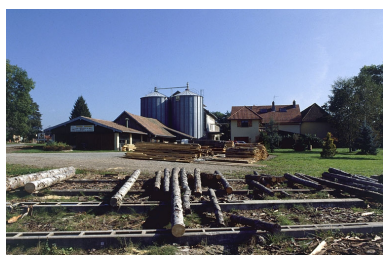
Scierie et minoterie depuis l'ouest. Phot. Yves Sancey IVR43_19999000156ZA
