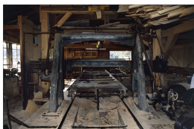
Châssis de scie et son chariot. Phot. Yves Sancey IVR43_19999000179ZA
