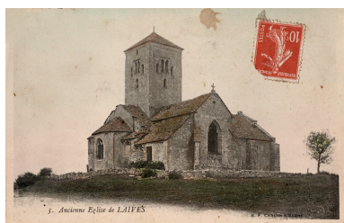
Vue ancienne. Autr. auteur inconnu IVR26_20237100155NUC4A
