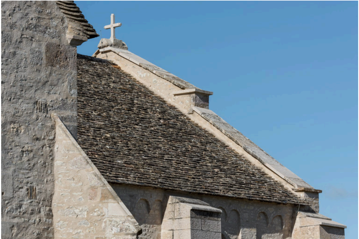
Couverture de la nef.
