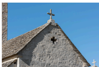
Pignon couvert de la façade.
