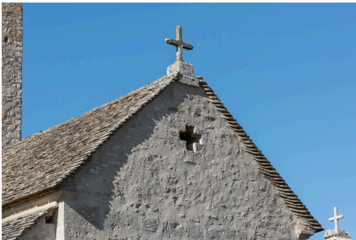
Pignon couvert de la façade.
