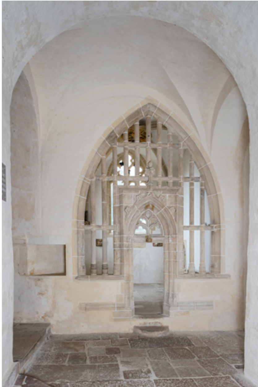
Chapelle de Jehan de La Grange, clôture vue depuis l'extérieur de la chapelle.
