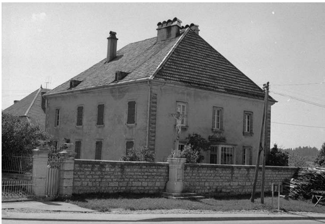
Façades antérieure et latérale gauche.
