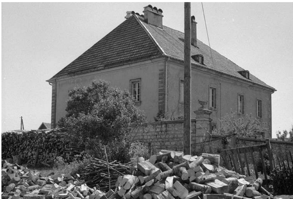
Façades postérieure et latérale gauche.
