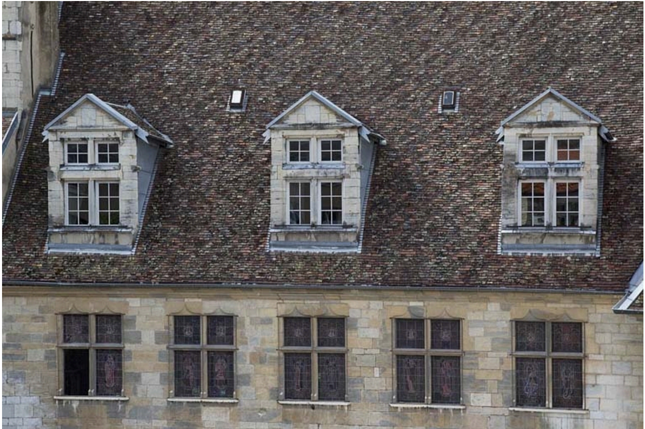
Logis principal, toiture : détail des lucarnes donnant sur l'extérieur.
