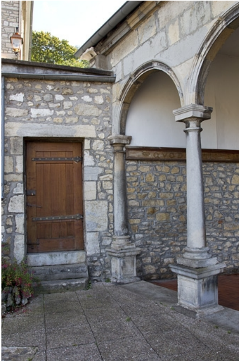
Détail d'une porte dans la clôture de jardin.
