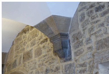
Logis principal, passage cocher : détail d'un support de la voûte. Phot. Yves Sancey IVR43_20112502759NUC2A
