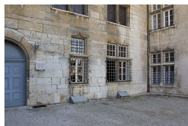
Logis principal, façade antérieure : détail du rez-de-chaussée de la partie droite. Phot. Yves Sancey IVR43_20112502762NUC2A
