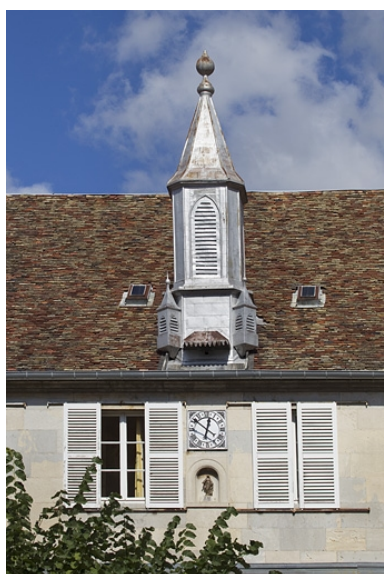
Logis principal, toiture, pan sur jardin : détail du clocheton. Phot. Yves Sancey IVR43_20112502746NUC2A
