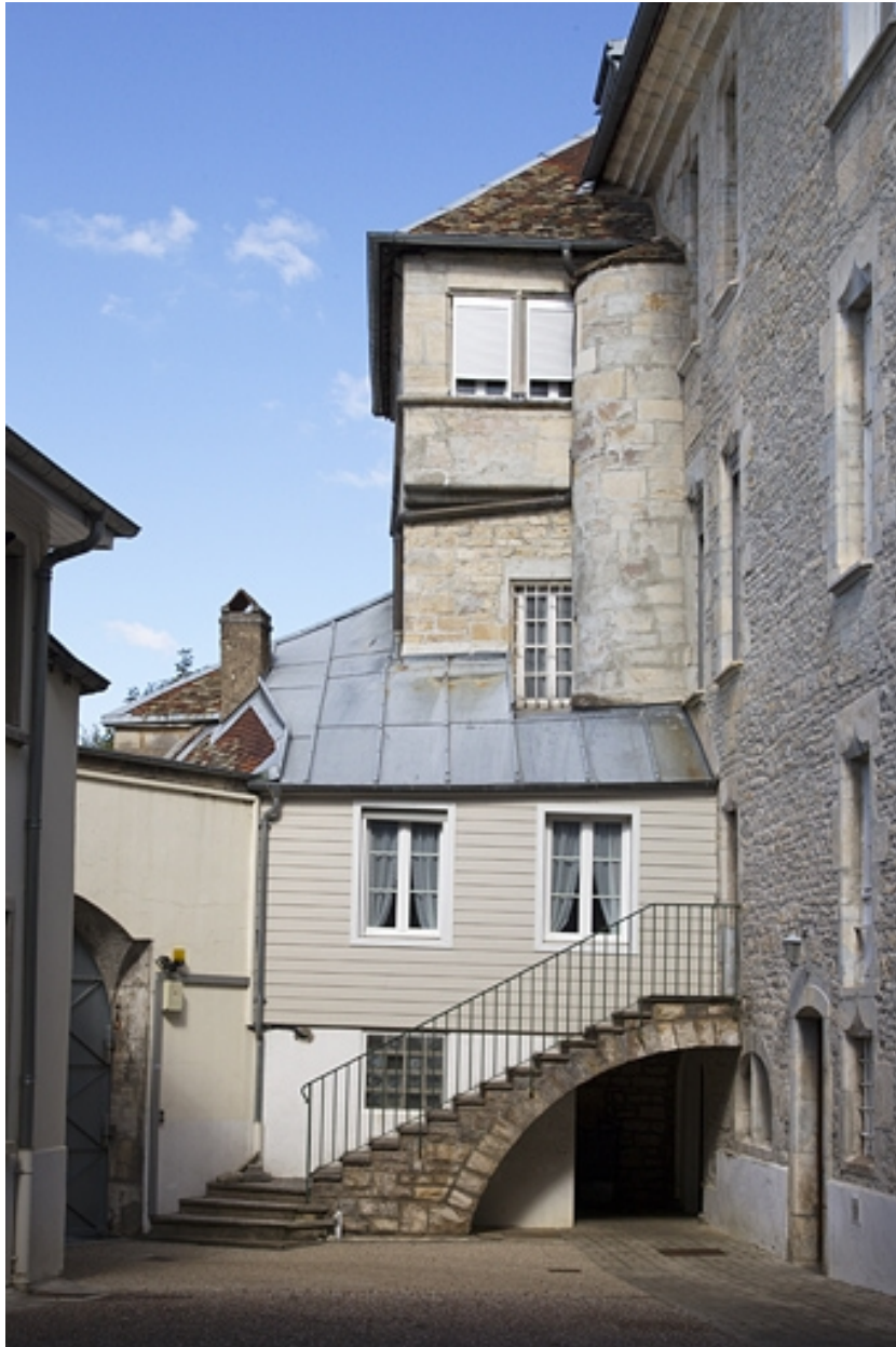
Détail de l'escalier extérieur depuis la cour basse.
