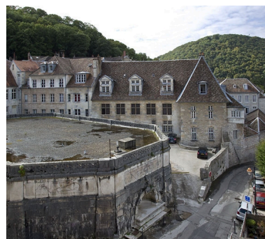
Vue d'ensemble de l'édifice depuis une fenêtre du vieil archevêché. Phot. Yves Sancey IVR43_20112502723NUC2A
