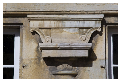
Logis principal, façade postérieure : détail d'une zapata du portique : de face. Phot. Yves Sancey IVR43_20112502763NUC2A
