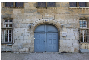
Logis principal, façade antérieure : détail du portail d'entrée. Phot. Yves Sancey IVR43_20112502761NUC2A
