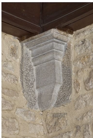
Logis principal, portique : détail d'une console supportant le plafond. Phot. Yves Sancey IVR43_20112502768NUC2A
