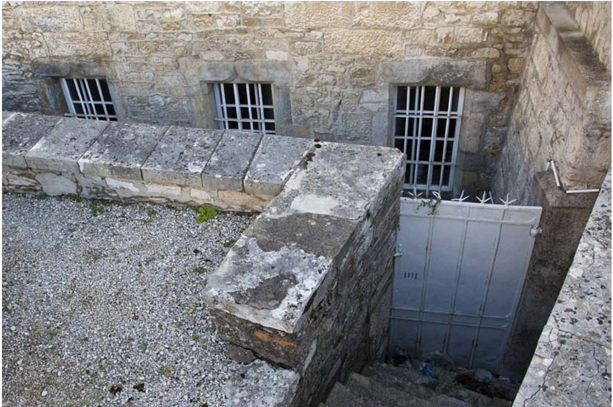
Logis principal, soubassement droit : détail de la cour anglaise devant les fenêtres de la cuisine.
