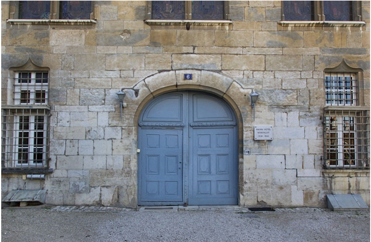
Logis principal, façade antérieure : détail du portail d'entrée.
