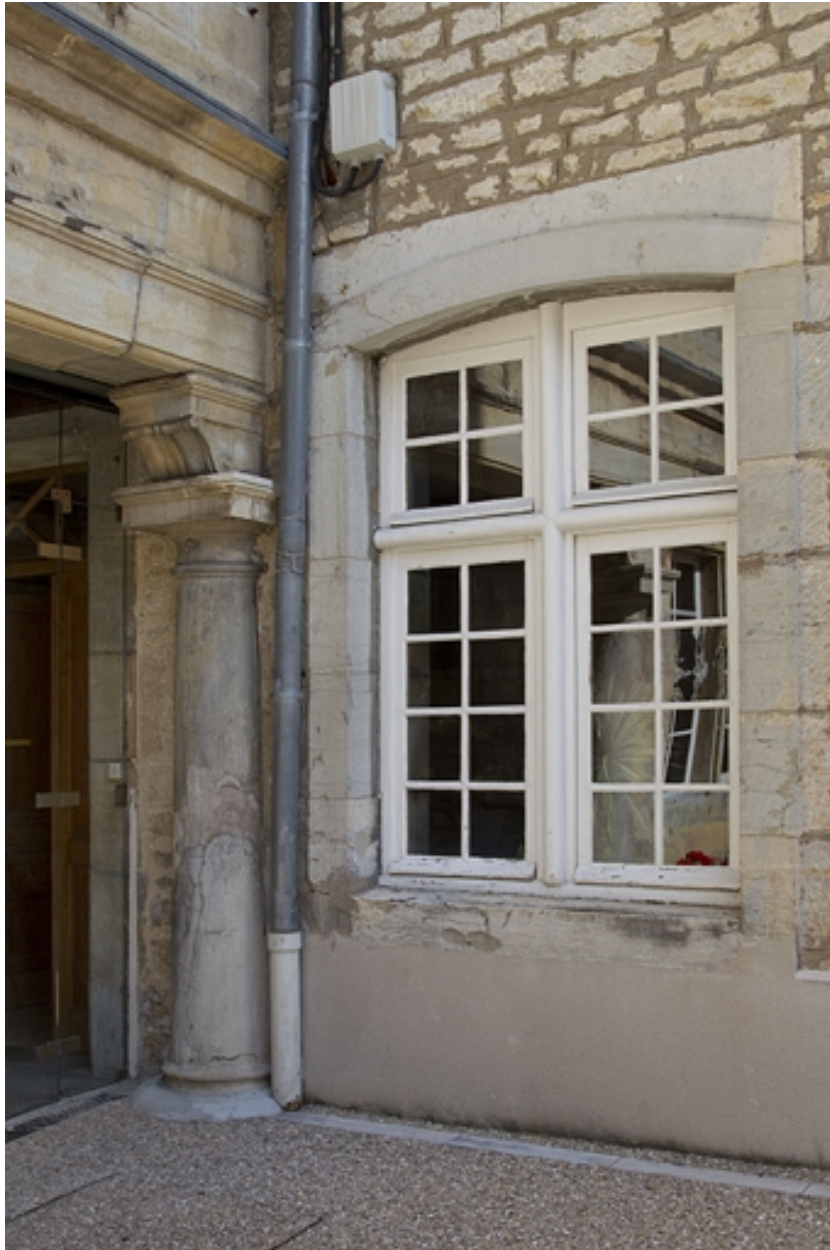
Logis principal, portique : détail de la colonne à l'extrémité droite.
