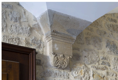
Logis principal, passage cocher : détail d'un support de la voûte. Phot. Yves Sancey IVR43_20112502760NUC2A
