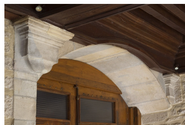
Logis principal, portique : détail de la partie supérieure d'une baie. Phot. Yves Sancey IVR43_20112502767NUC2A
