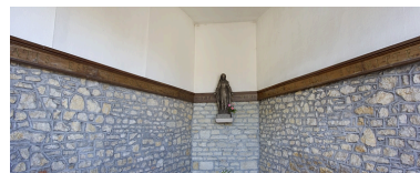
Fabrique de jardin : vue de l'intérieur, de face. Phot. Yves Sancey IVR43_20112502725NUC2A
