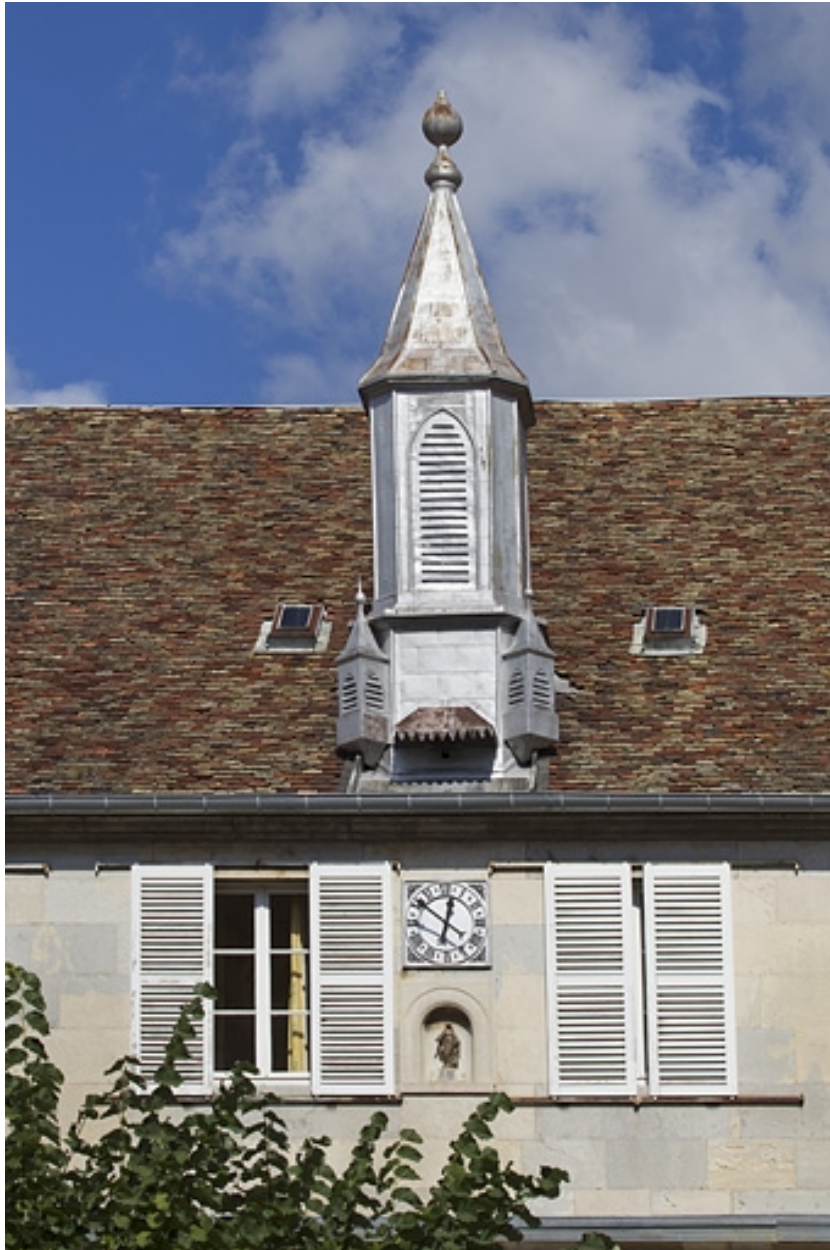
Logis principal, toiture, pan sur jardin : détail du clocheton.
