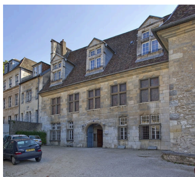
Logis principal, façade antérieure : de trois quarts droit. Phot. Yves Sancey IVR43_20112502734NUC2A
