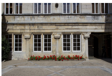
Logis principal : vue d'ensemble du portique. Phot. Yves Sancey IVR43_20112502748NUC2A
