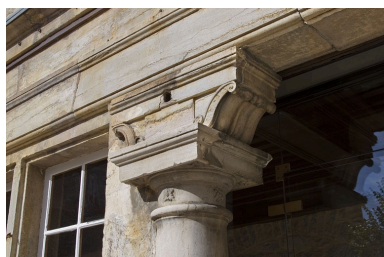
Logis principal, façade postérieure : détail d'une zapata du portique, de trois quarts droit. Phot. Yves Sancey IVR43_20112502764NUC2A
