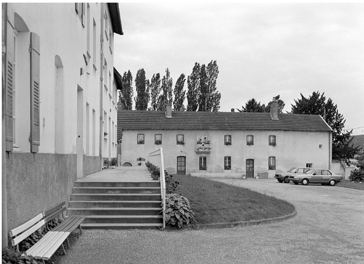
Vue d'ensemble du bâtiment droit.
