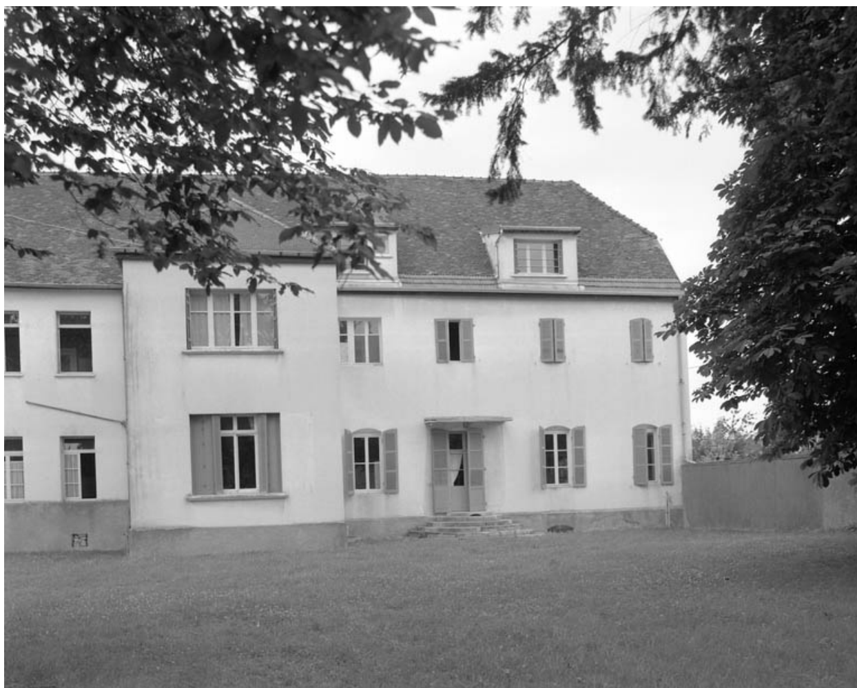
Façade postérieure du bâtiment principal : partie droite.
