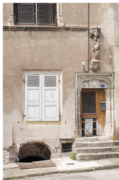
Façade antérieure : détail du rez-de-chaussée.
