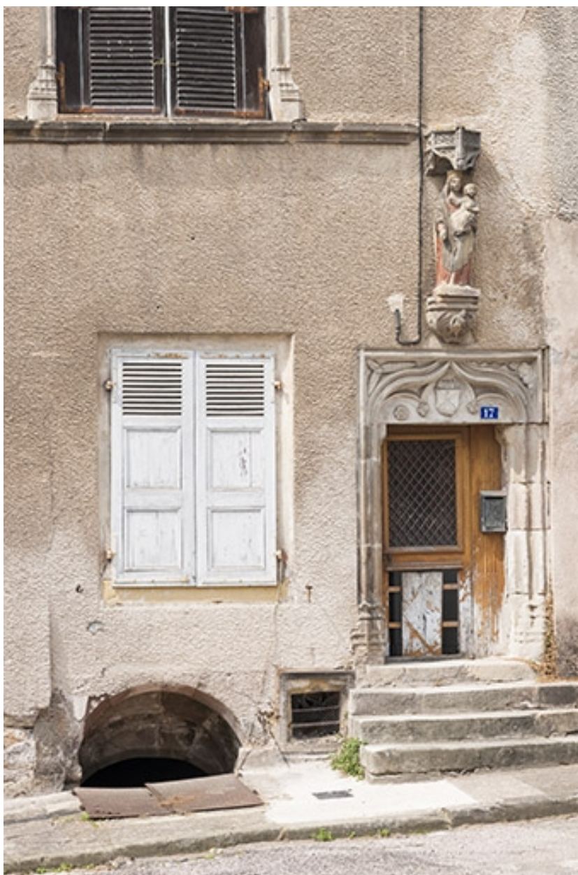
Façade antérieure : détail du rez-de-chaussée.
