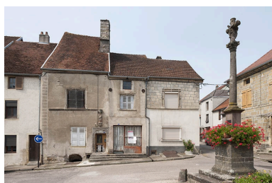
Vue générale depuis la place de la mairie. Phot. Jérôme Mongreville IVR43_20137000029NUC4A
