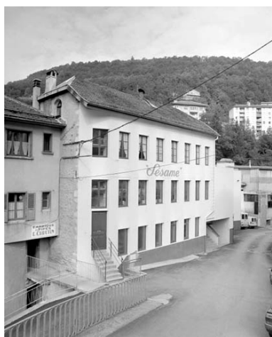
Façade antérieure de l'ancienne usine. Phot. Jérôme Mongreville IVR43_19923900543X
