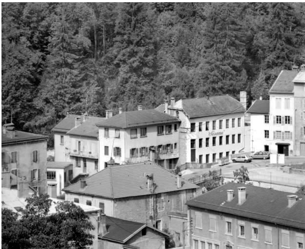
Vue d'ensemble plongeante depuis le sud-est.
