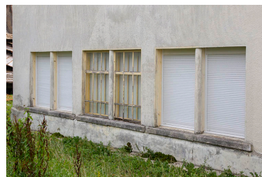
Usine : fenêtres horlogères de la façade postérieure. Phot. Yves Sancey IVR43_20122502291NUC2A
