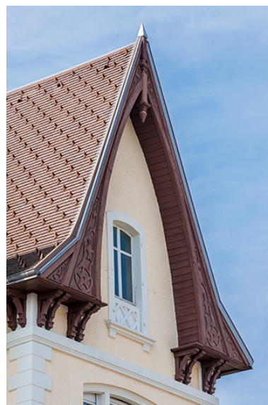
Logement patronal : pignon de la façade antérieure. Phot. Jérôme Mongreville IVR43_20142500182NUC4A
