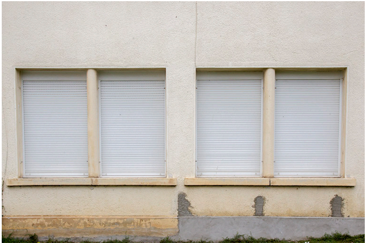
Usine : fenêtres horlogères de la façade antérieure.
