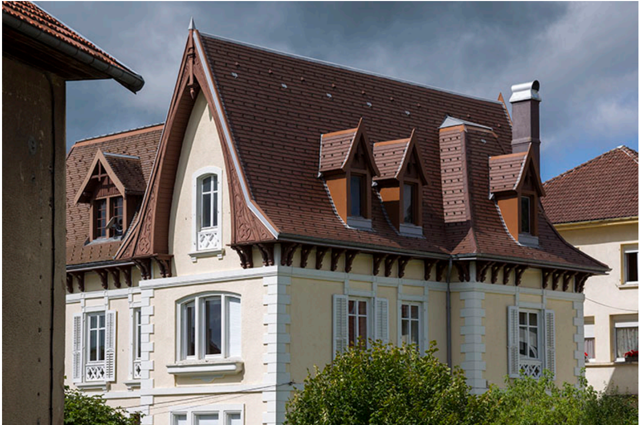
Logement patronal : étages supérieurs et toiture, vus de l'ouest.
