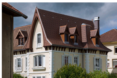
Logement patronal : étages supérieurs et toiture, vus de l'ouest. Phot. Sonia Dourlot IVR43_20142501800NUC2A
