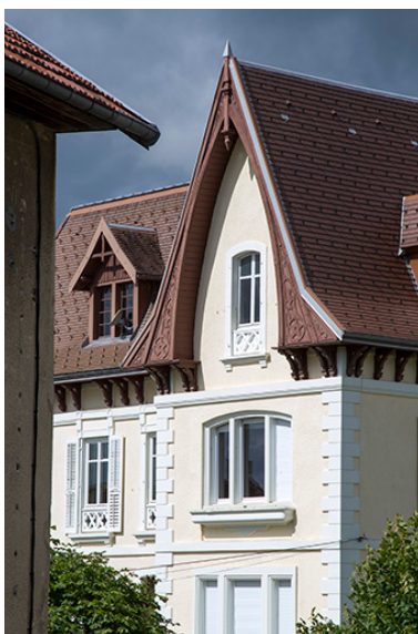
Logement patronal : étages supérieurs, toiture et pignon de la façade antérieure, vus de l'ouest. Phot. Sonia Dourlot IVR43_20142501799NUC2A
