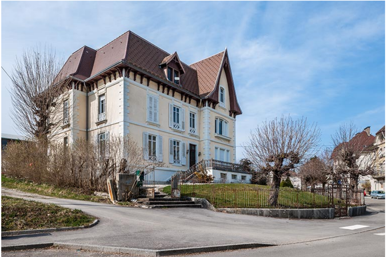
Logement patronal : façade antérieure, de trois quart gauche.
