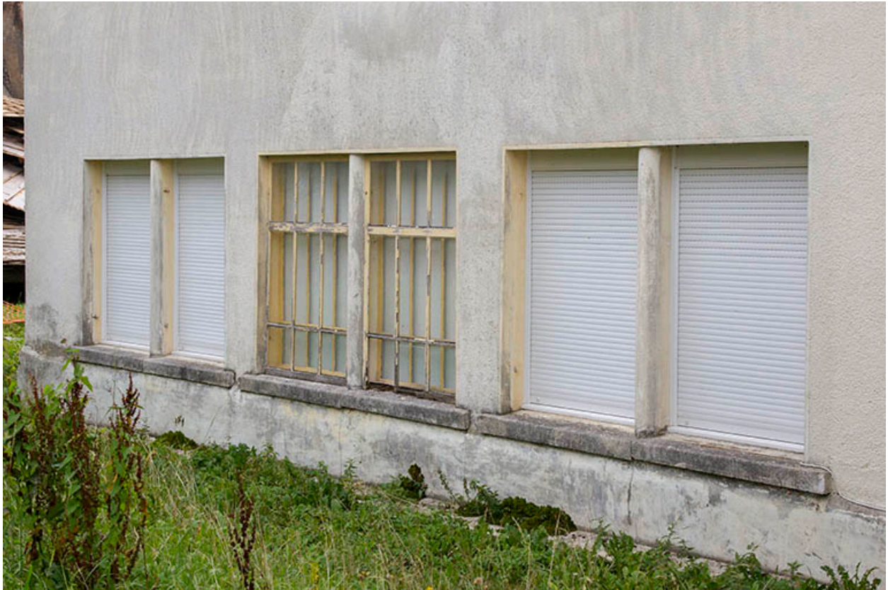
Usine : fenêtres horlogères de la façade postérieure.
