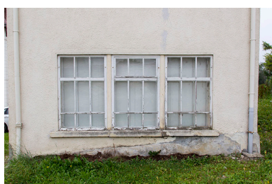
Usine : fenêtres multiples de la façade latérale droite. Phot. Yves Sancey IVR43_20122502289NUC2A
