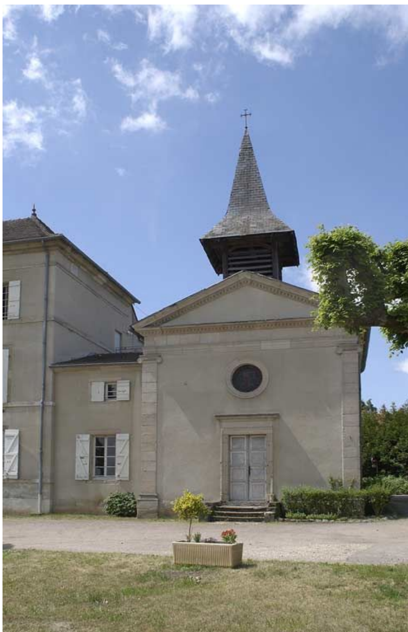
Façade antérieure de la chapelle.
