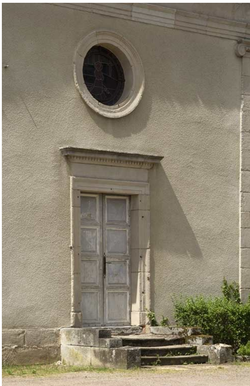
Porte de la chapelle surmontée d'un oculus.
